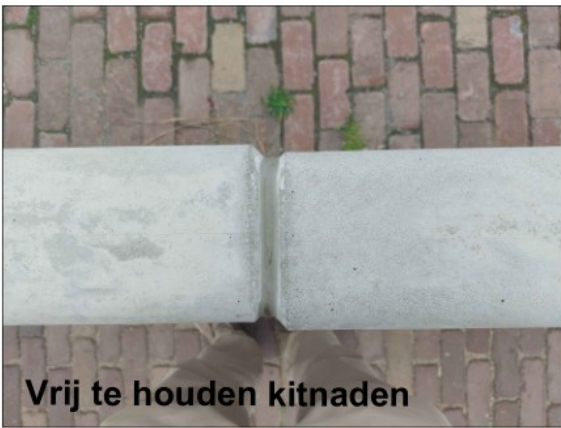
Bestaande situatie waterzijde
