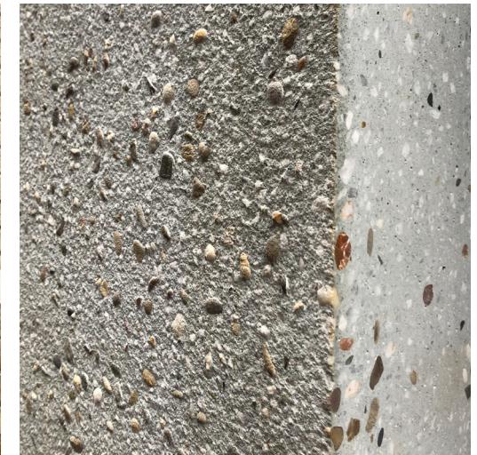
gewassen beton zorgt op een subtiele manier voor extra plasticiteit van de gevel
