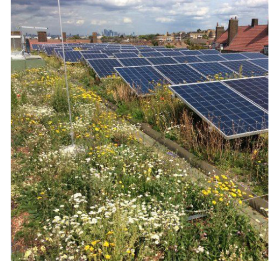
PV panelen worden zorgvuldig geïntegreerd Clapham Park, The Bauder BioSOLAR system, Londen
