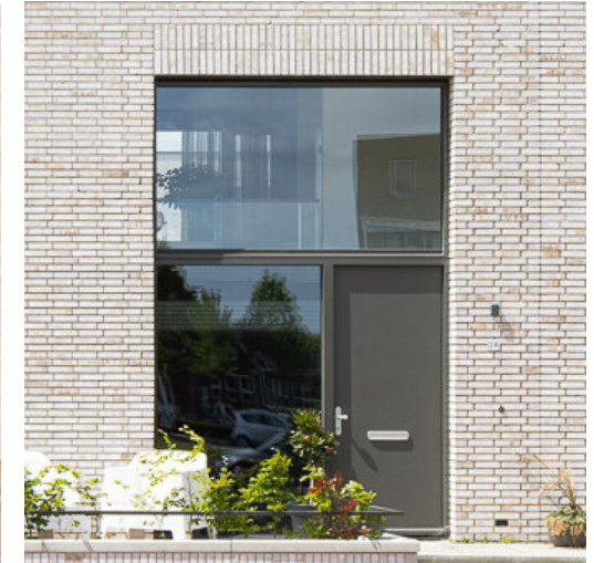
Gevelopening afgewerkt met een rollaag, Janninkkwartier, Zecc, Enschede,
