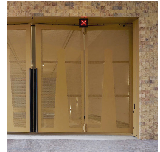
Verdiept gelegen entree autoparkeervoorziening met geperforeerde speedgates.
