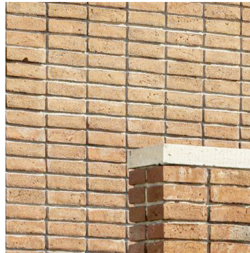
diep voegwerk draagt bij aan een robuuste uitstraling van het gebouw
