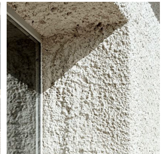
grof stucwerk zorgt voor extra schaduwwerking
