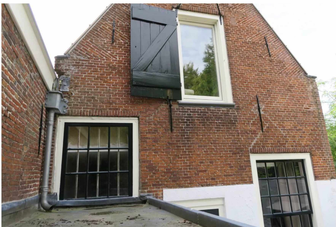
Foto 15 Platdak aanbouw binnenplaats met overzicht dakaansluitingen rondom.
