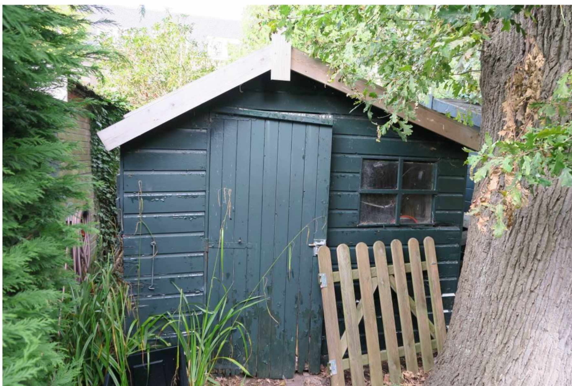
Foto 27 Twee vrijstaande houten bergingen in de achtertuin ter plaatse van de aanbouw kopgevel.
