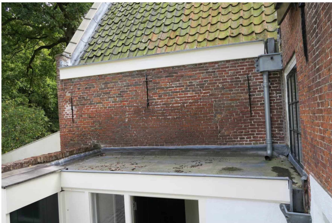
Foto 14 Platdak aanbouw binnenplaats met overzicht dakaansluitingen rondom.
