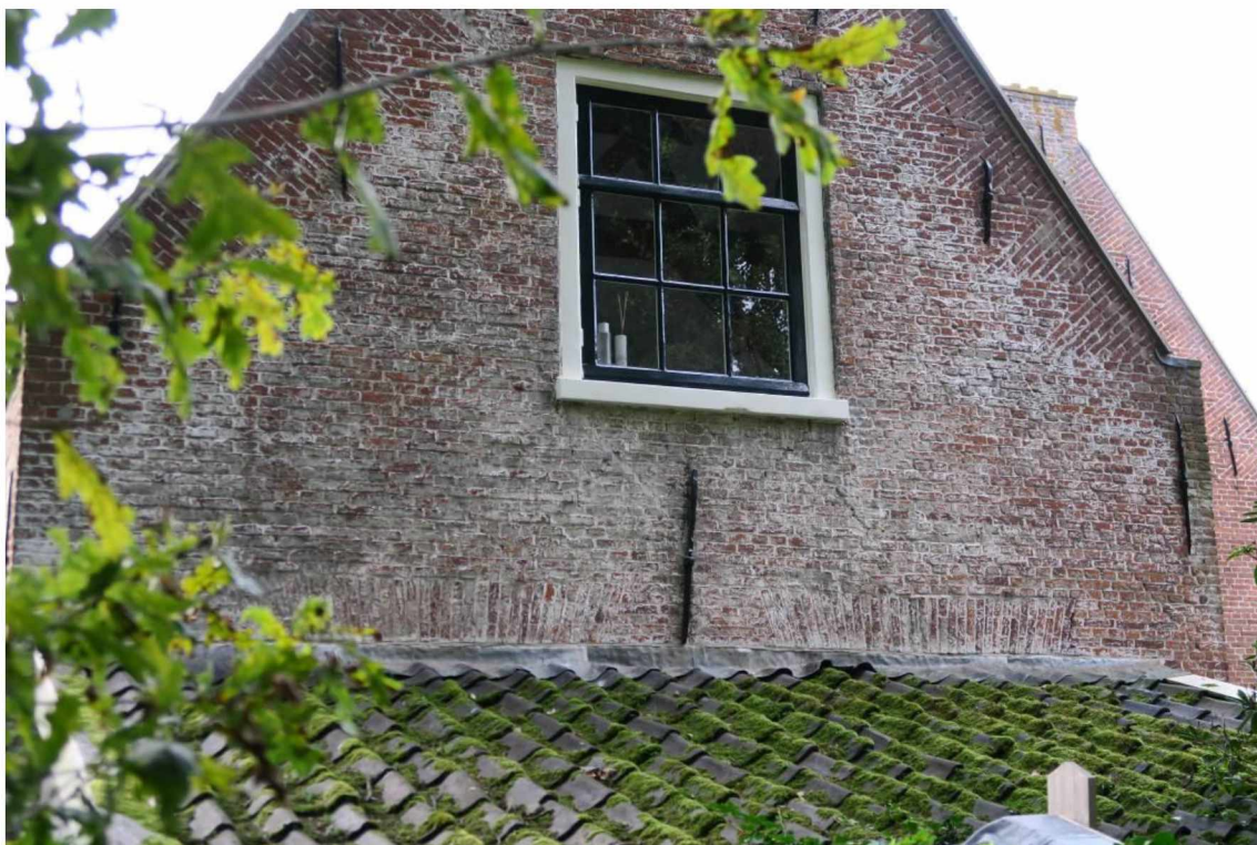
Foto 20 Aanbouw schuur tegen tweede kopgevel woning.
