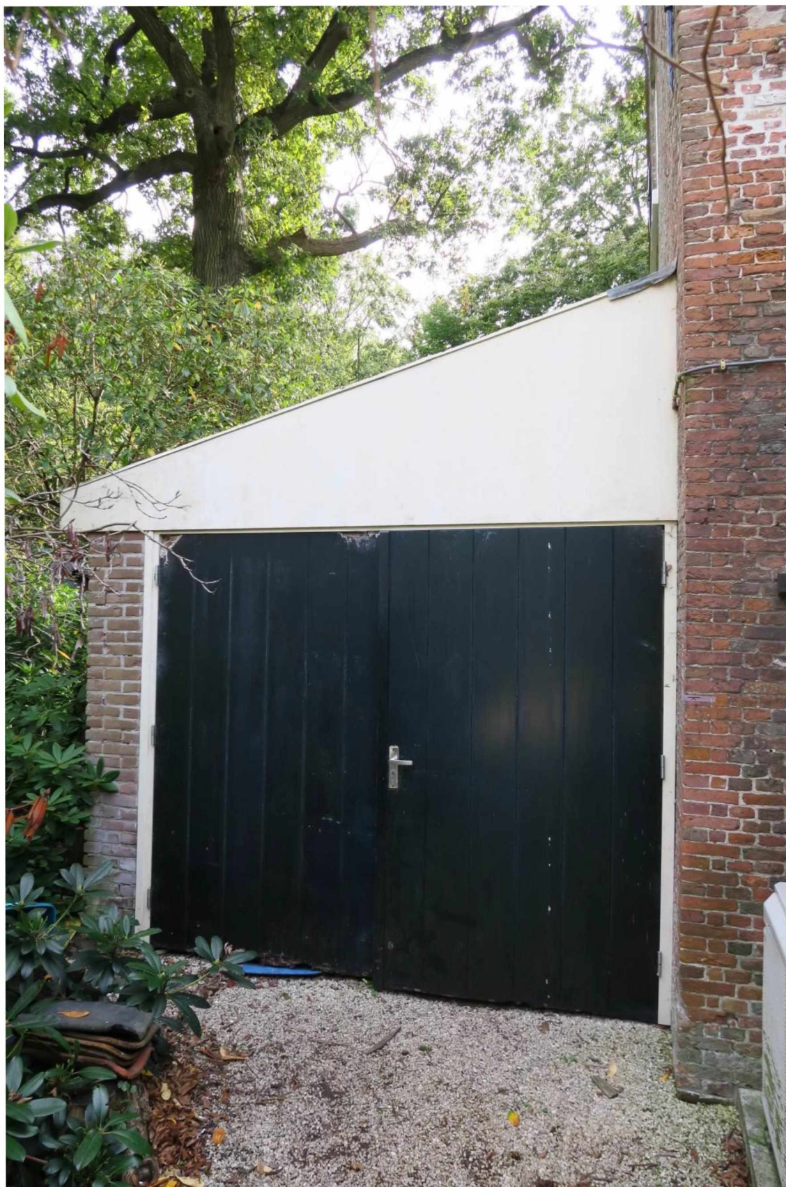
Foto 19 Aanbouw schuur tegen tweede kopgevel woning.
