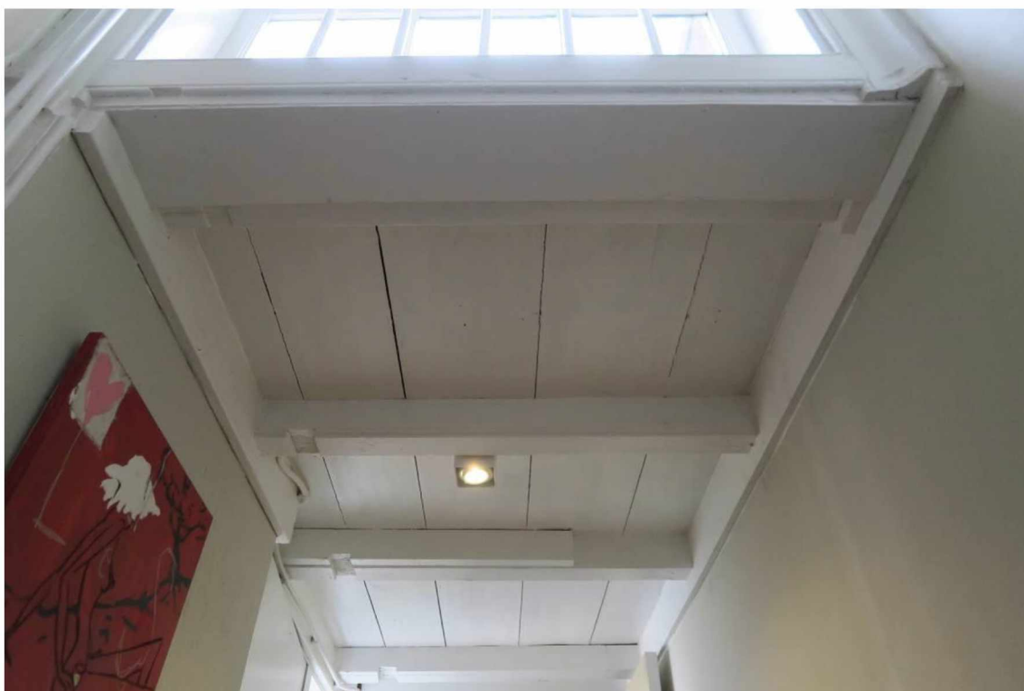
Foto 18 Gang woning ter plaatse van de entree aanbouw binnenplaats.
