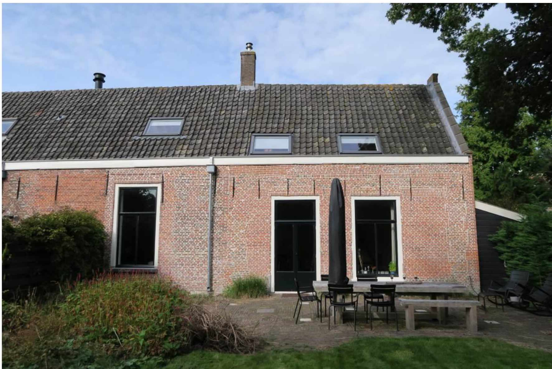
Foto 25 Tuingevel gezien vanuit de achtertuin. Rechts zichtbaar de aanbouw tegen de kopgevel.
