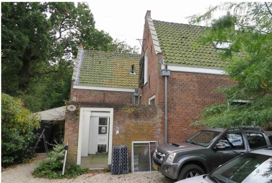
Foto 6 Entree woning via binnenplaatsje.
