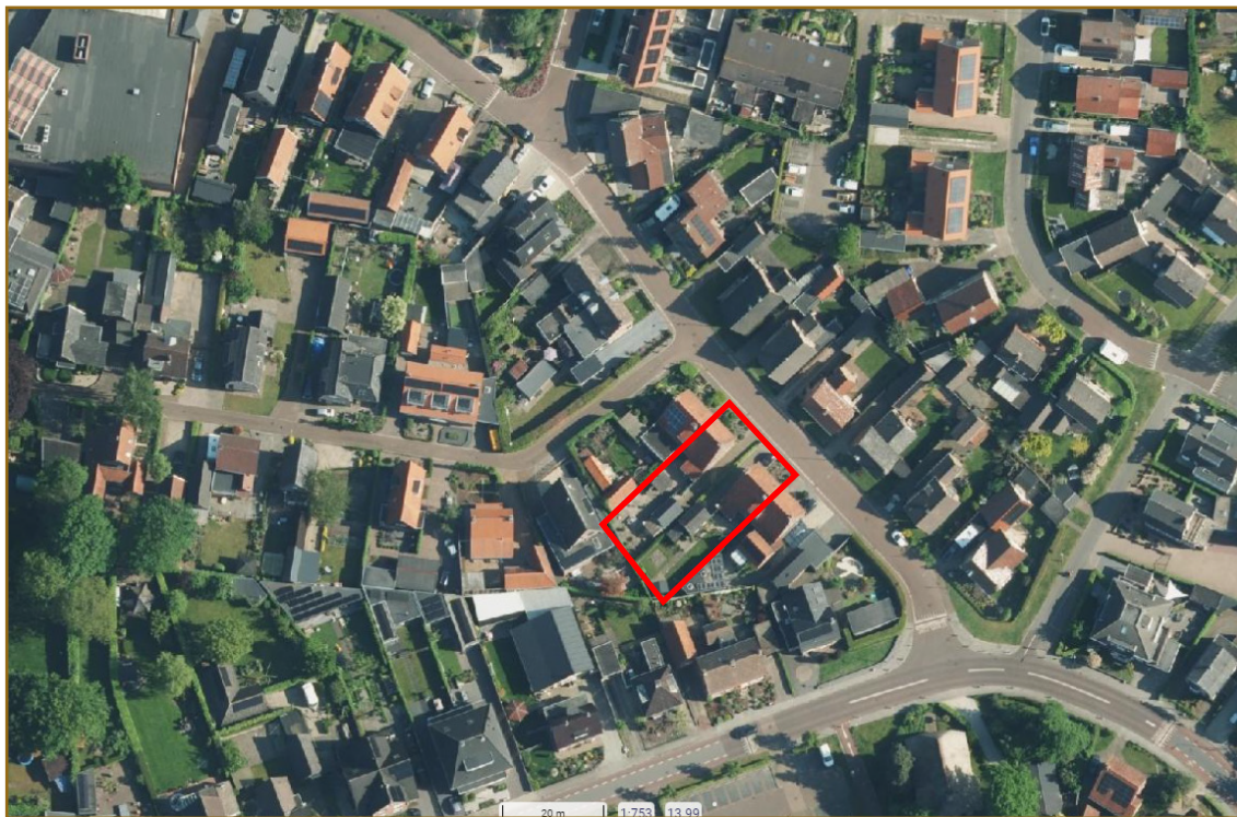
Afbeelding 1.4: Luchtfoto met woningen behorend tot cluster 301.002 (rood kader). Het betreft twee helften van verschillende tweekappers. De andere helften zijn in het verleden verkocht en sindsdien in particulier bezit. Bron: PDOK luchtfoto.
