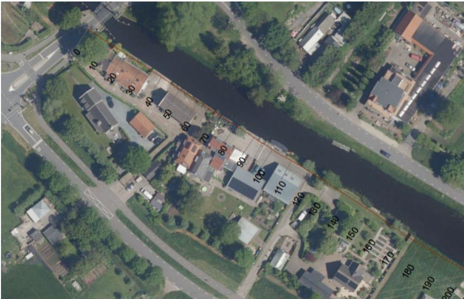
Figuur 3.1: Eerste 170 meter dijktraject V231 nabij de Hakkelaarsbrug
