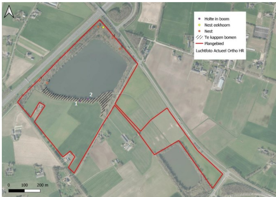
Figuur 3. Resultaten van het actualisatie onderzoek uit 2024. Nest 1 (oranje stip)= mogelijk in gebruik door Havik of Sperwer, nest 3 (oranje stip) = Buizerd nest. Boom met holte 2 (parse stip) = potentiële vleermuisverblijfplaats.
