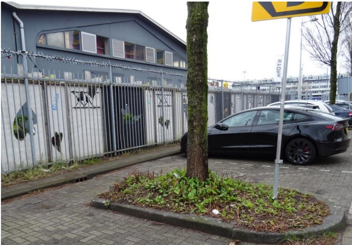
Langs het Gedempte Hamerkanaal is een deel van de bomen in onnodig kleine boomspiegels geplaatst met daarachter een kolk. Dit veroorzaakt meerdere problemen nu en in de toekomst.
