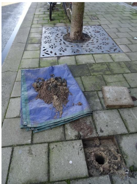
Grondboring in de Hamerstraat
