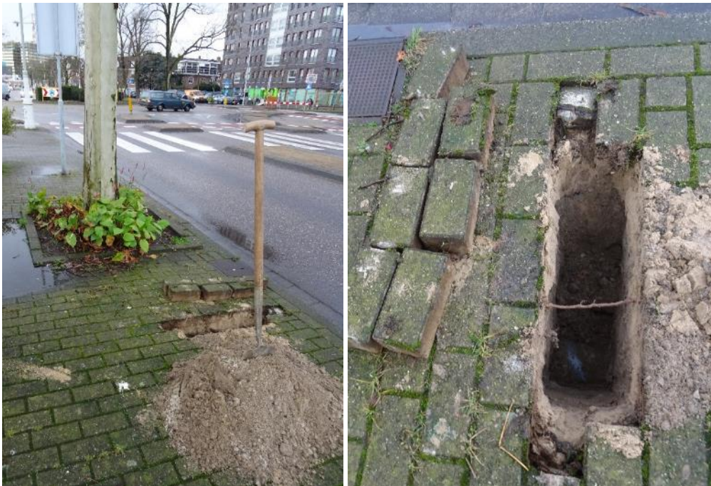
Boom 39 met riooltracé door de profielsleuf
