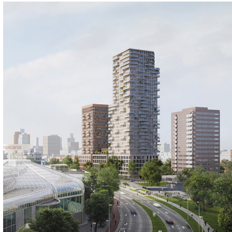
Hoogteaccent markeert de brug over het spoor
