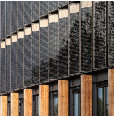
Energie-opwekking (zonnepanelen) als onderdeel van de architectuur (gevel/daken)
