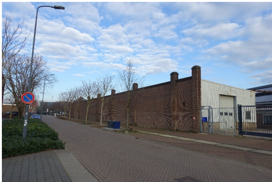
Afb. 136 De muur, gezien uit het zuidwesten, met daartegen vernieuwd bouwdeel 12.
