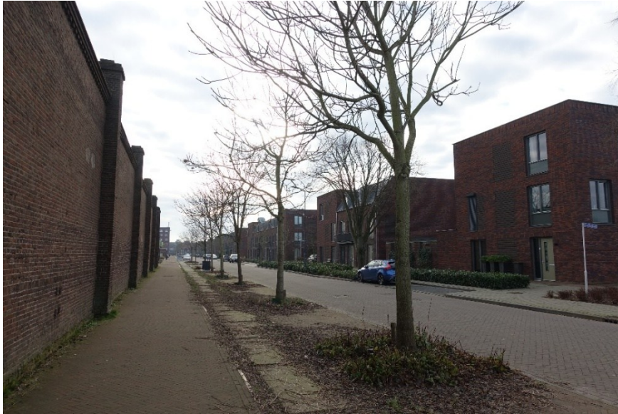
Afb. 103 Zicht door de Paardskerkhofweg in zuidelijke richting, met links de historische muur rond het oorspronkelijke fabrieksterrein van Grasso.
