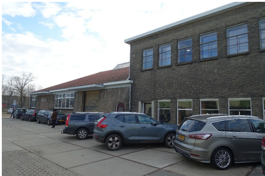
Afb. 165 Het tweelaags deel van de noordgevel heeft nog grotendeels de oorspronkelijke vensters met stalen ramen.
