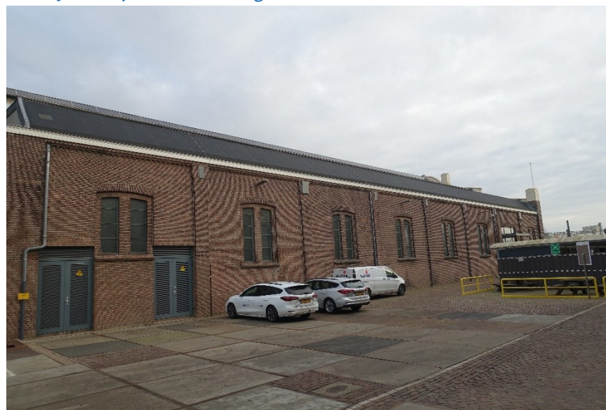
Afb. 120 Oostelijk deel van de zuidgevel.
