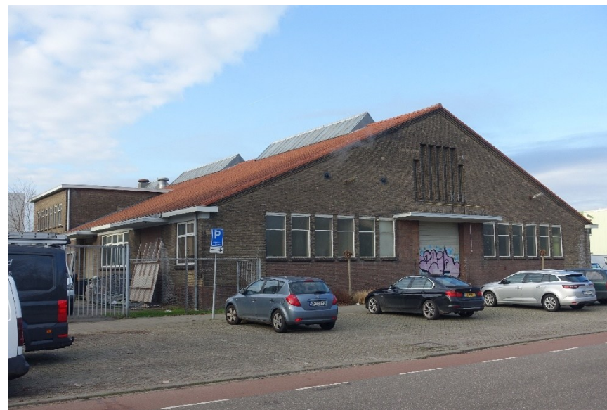
Afb. 160 Oostgevel van het voormalige veilinggebouw.
