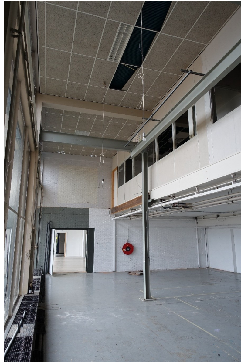
Afb. 183 In de huidige ingebouwde verdieping zijn geen herkenbare overblijfselen van de kort na de bouw ingevoegde galerij herkenbaar.
