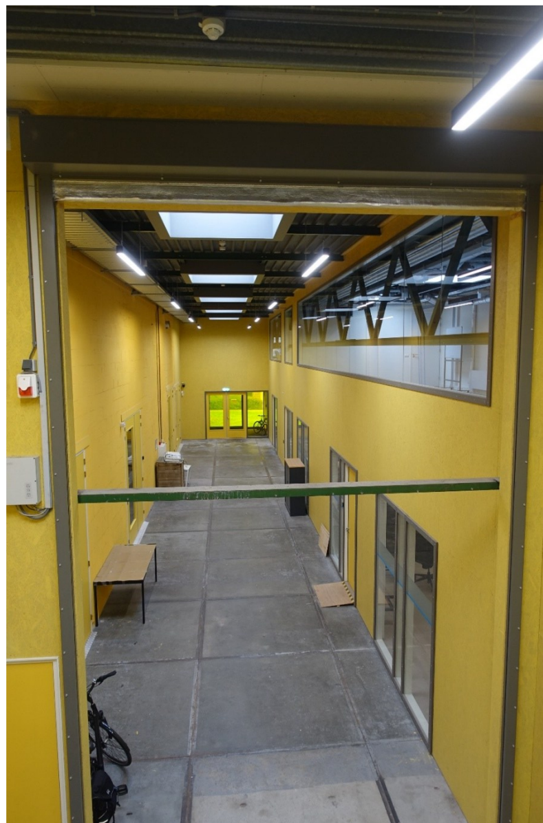
Afb. 208 De centrale dwarsgang in gebouw 14. Binnen het gebouw werd deels een verdiepingvloer ingevoegd.
