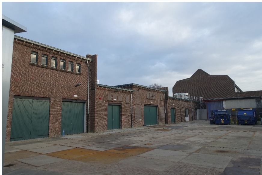
Afb. 121 Overzicht zuidgevel van de achtervleugel.
