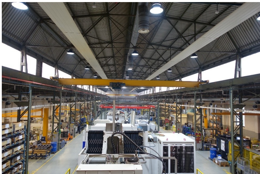
Afb. 125 Interieur van de noordelijke brede hal, gezien in westelijke richting.
