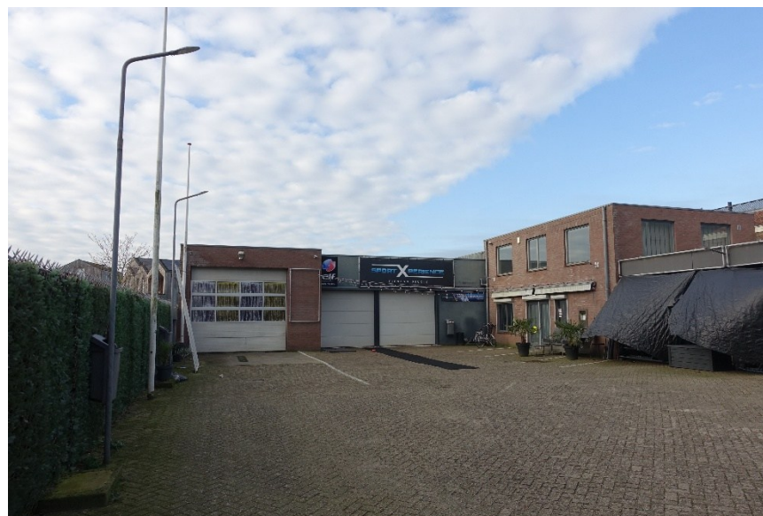
Afb. 221 Voorzijde (oost) van de sterk verbouwde voormalige meubelfabriek.
