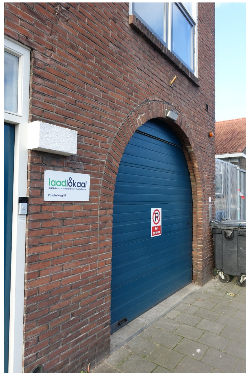
Afb. 210 Detail boogopening met vernieuwde deur.
