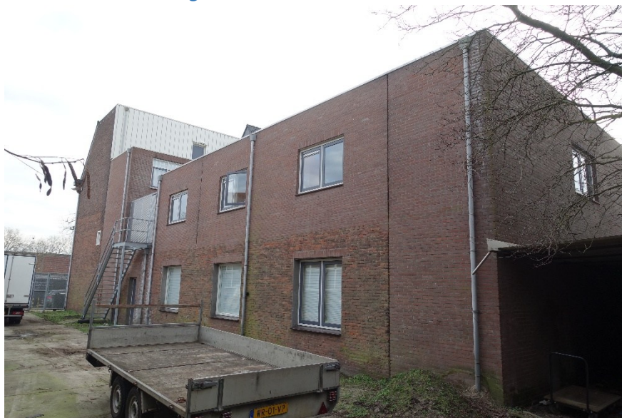
Afb. 212 Overzicht van de tot twee bouwlagen verhoogde, oorspronkelijk enkellaags fabriek.
