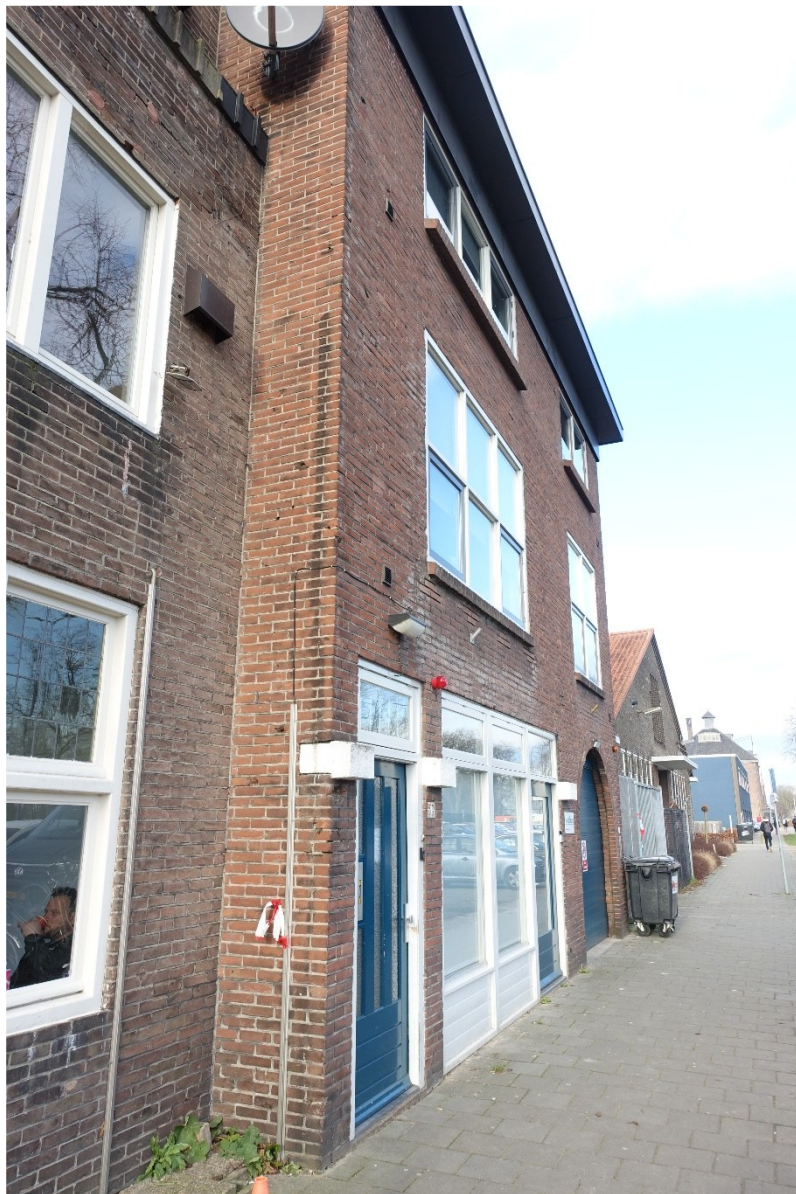
Afb. 209 Overzicht voorgevel van het pand.
