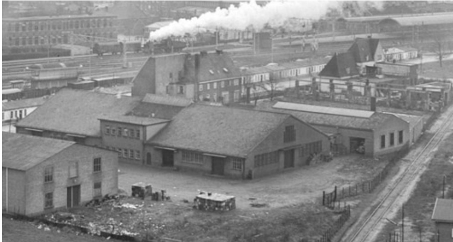
Afb. 81 Zicht op de achterzijde van het complex in 1956, na de uitbreiding van de veiling. De opvallende hoge achtergevel met lagere uitbouw en hoge schoorsteen van de cv-ruimte zijn duidelijk herkenbaar. EDB, nr. 0067243 (P. Farla).
