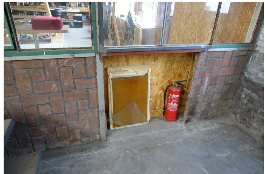
Afb. 172 Borstwering met siermetselwerk.
