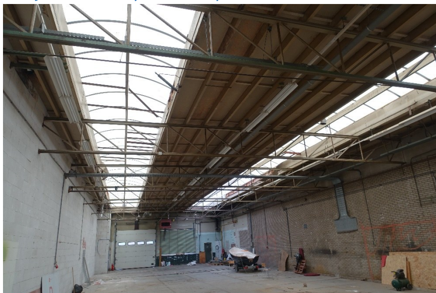
Afb. 197 Interieur van het ongedeelde westelijke deel van bedrijfshal 6.
