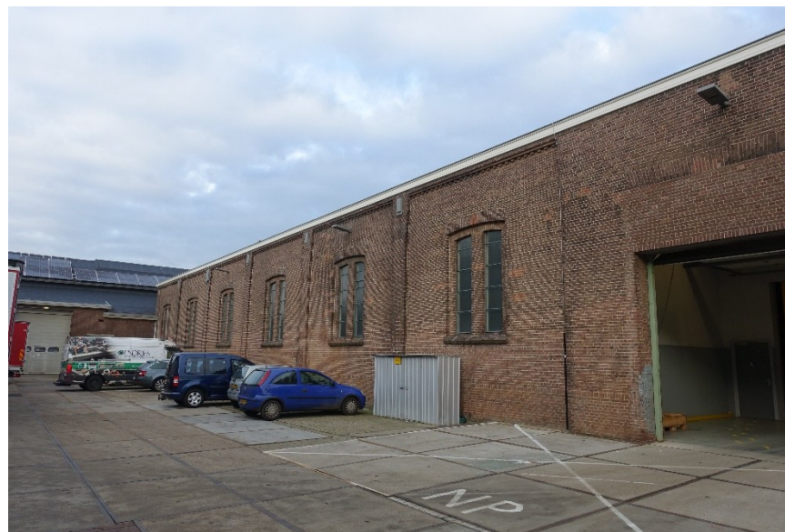
Afb. 119 Westelijk deel van de zuidgevel.
