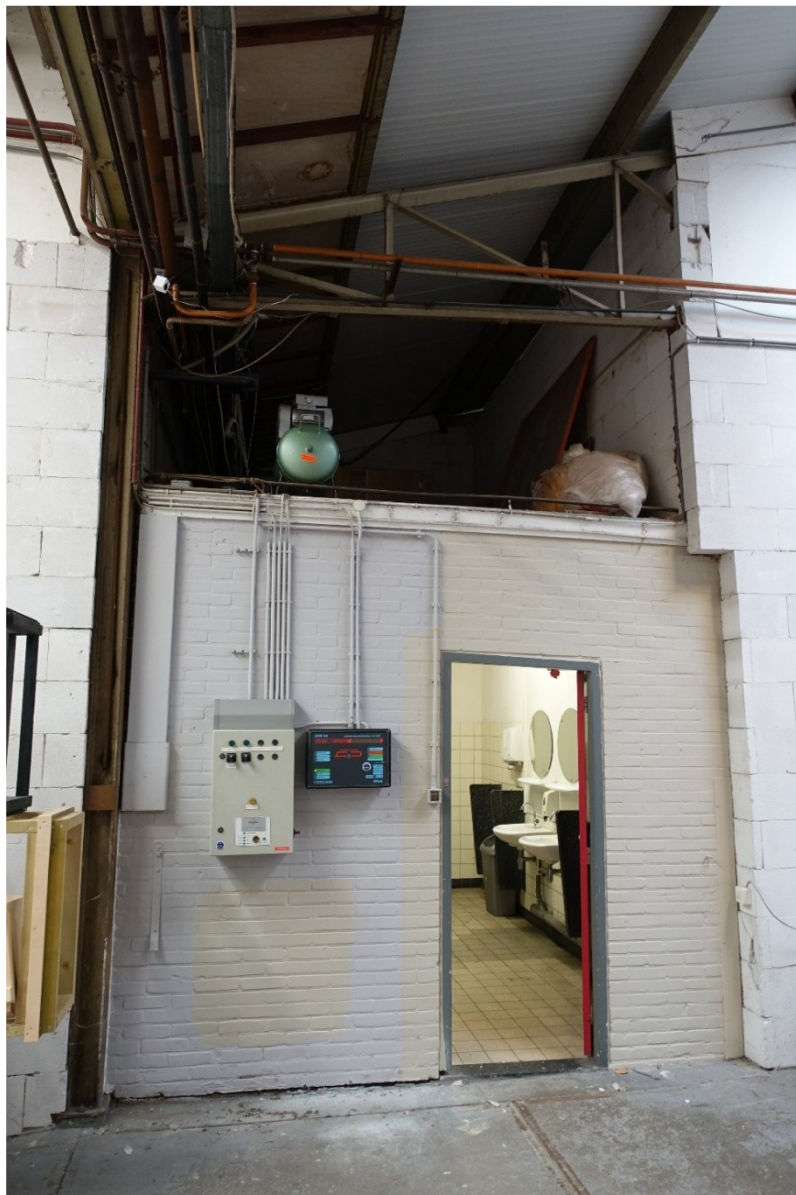
Afb. 191 Oorspronkelijke toiletgroep tegen de (vroegere) zuidgevel.
