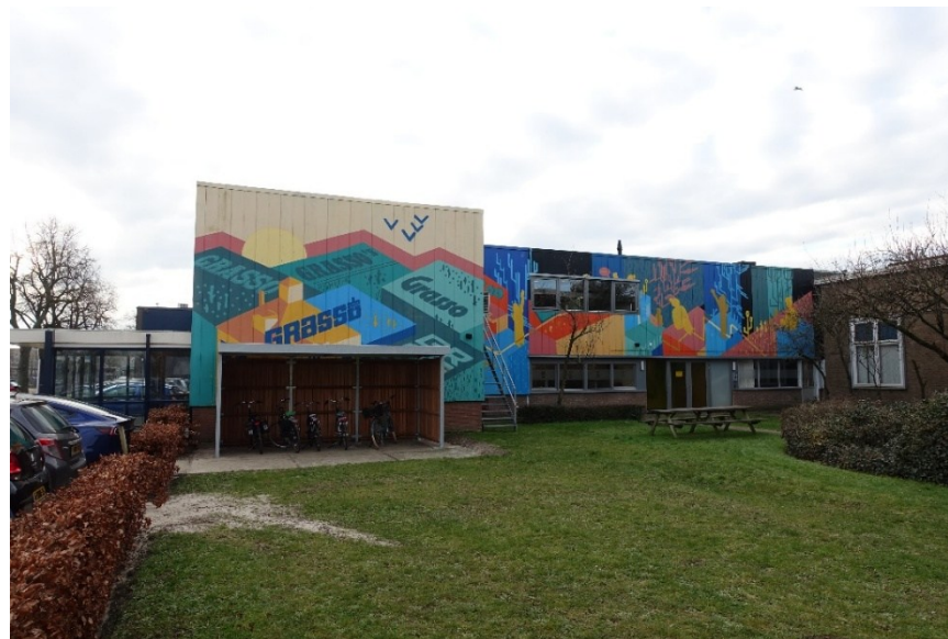
Afb. 201 Noordgevel van gebouw 7.
