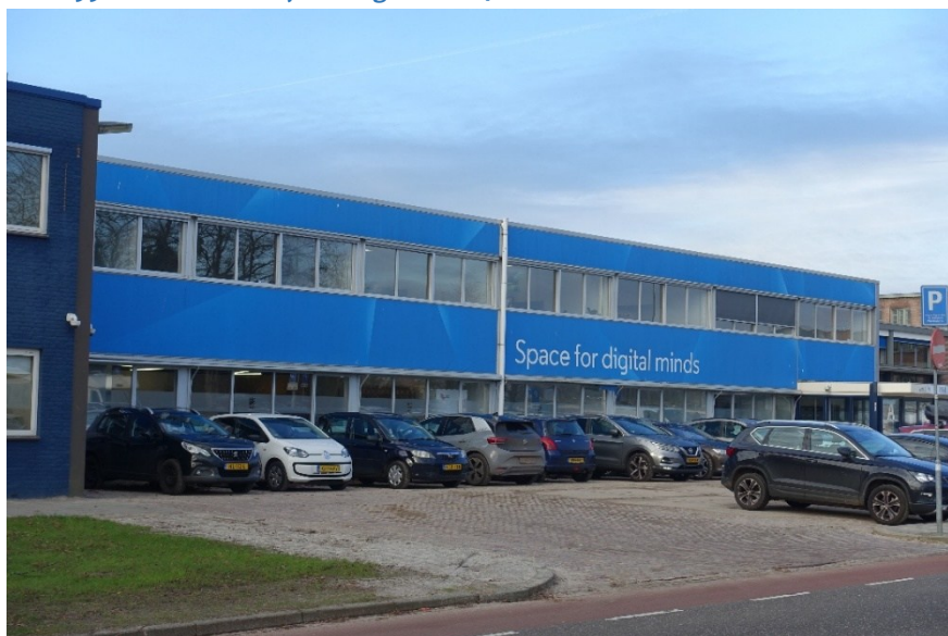
Afb. 200 Oostgevel van gebouw 7.
