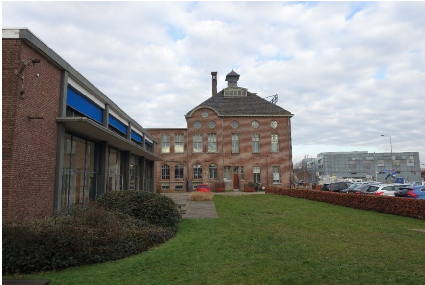
Afb. 99 Niet alleen het op de achtergrond zichtbare kantoorgebouw van de Grasso-fabriek heeft een prominenten hoge voorbouw. Ook de aan de linkerkant zichtbare showroom fungeert als representatieve voorbouw voor de achterliggende bedrijfshal.
