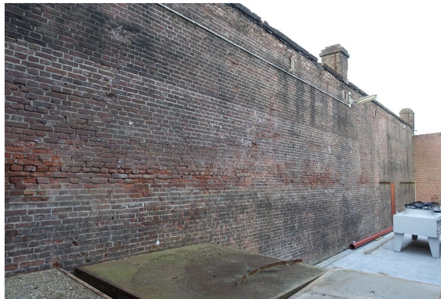
Afb. 134 Bij het noordelijke deel zijn de afgezaagde balken van het afdak nog zichtbaar.
