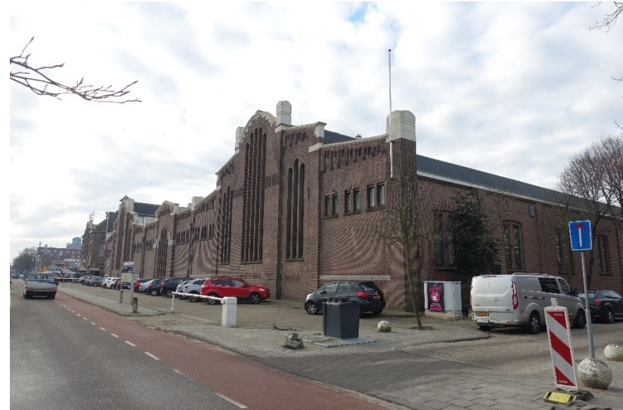
Afb. 115 Overzicht van de voorgevel uit het noordoosten.
