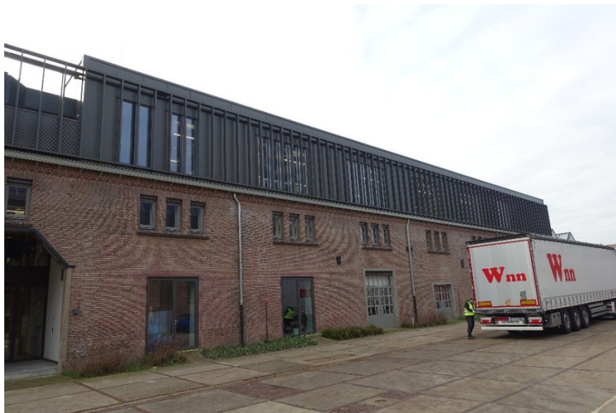
Afb. 148 Boven het oorspronkelijk enkellaags fabrieksgedeelte werd een nieuwe opbouw toegepast.
