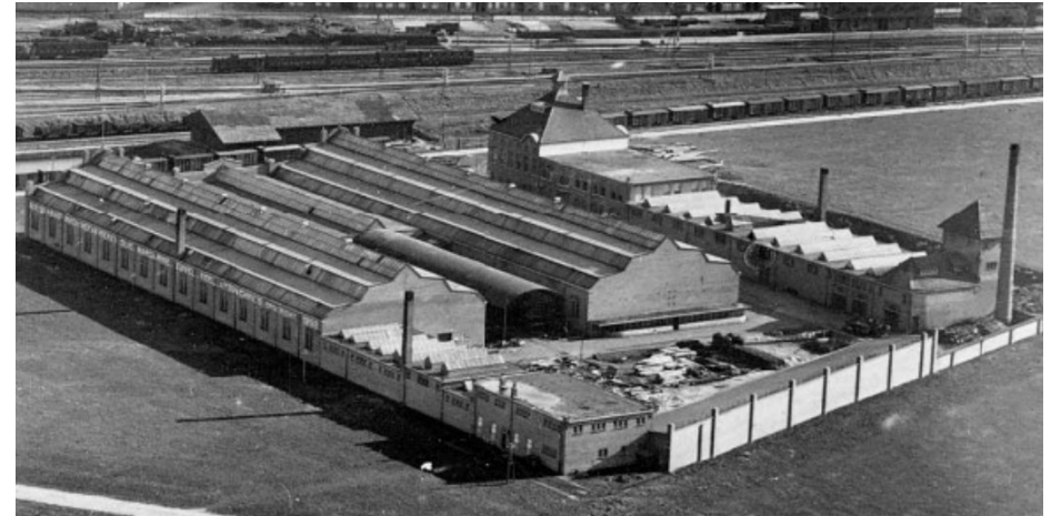
Afb. 33 Mooi overzicht van de fabriek uit het noordwesten in 1924. Tussen de noordelijke en zuidelijk hal is hier goed de met een gebogen dak overdekte binnenplaats herkenbaar. EDB, nr. 0076606.
