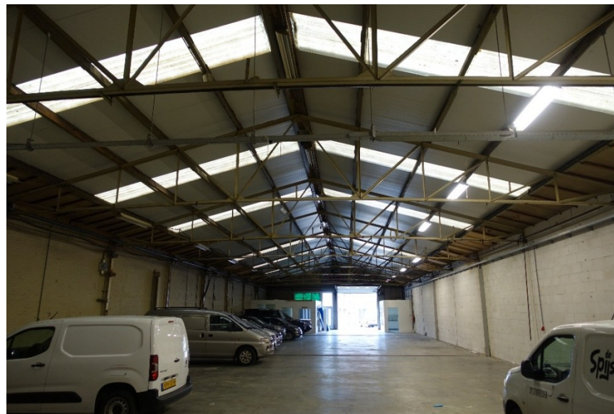
Afb. 190 In de grote zuidwestelijke ruimte is goed de constructie zichtbaar.
