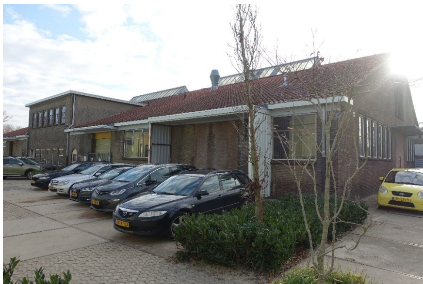
Afb. 166 Noordwesthoek, met ook hier een dichtgemetselde deuropening.
