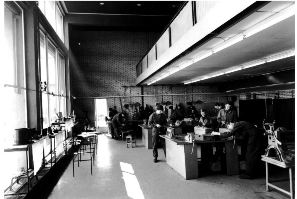
Afb. 62 Interieur zuidelijk deel van de Grasso bedrijfsschool omstreeks 1967. EDB, nr. 22844 (P. Farla).
