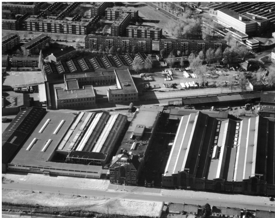
Afb. 70 Op deze luchtfoto uit oktober 1976 is links de zojuist gereed gekomen hal met aangebouwde kantoorvleugel zichtbaar. Ten zuiden daarvan bevindt zich nog de emballagehal van de groenteveiling. EDB, nr. 31847-3.
