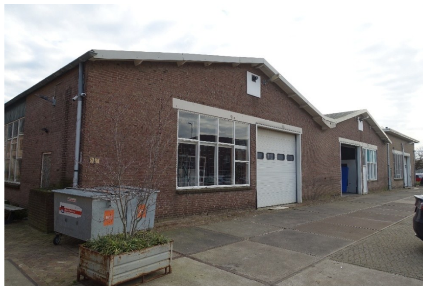
Afb. 187 Overzicht van de met twee topgevels uitgevoerde westgevel.
