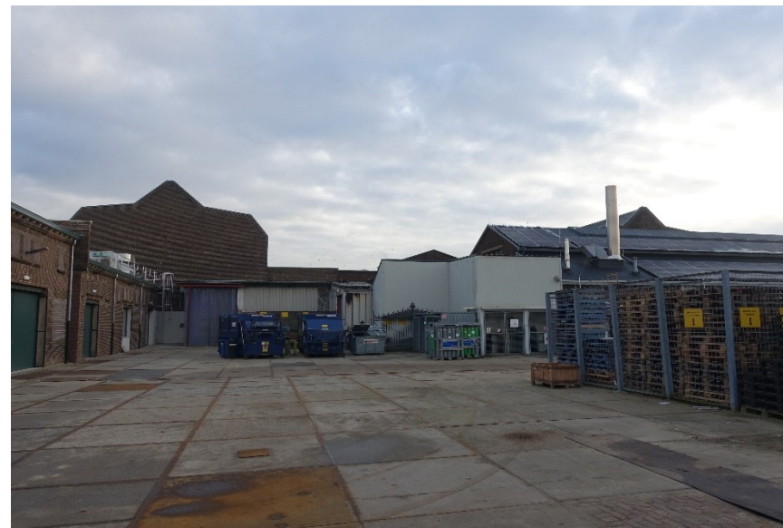
Afb. 137 Overzicht latere bouwdelen in de binnenhoek tussen de fabriekshallen (midden), de achtervleugel (links) en de expeditieloods (rechts).
