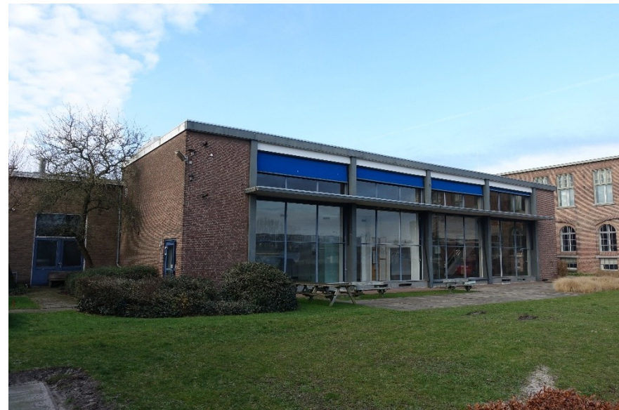
Afb. 180 De voorgevel, gezien over het bijbehorende gazon.
