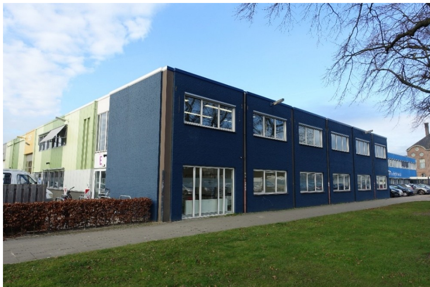
Afb. 199 Overzicht oostzijde van gebouw 14.
