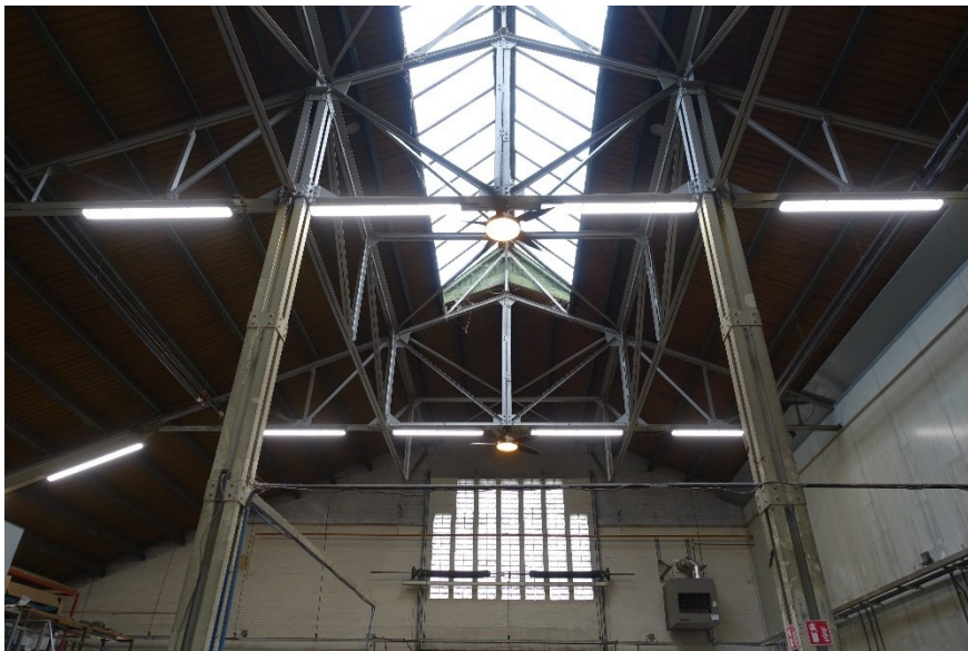
Afb. 170 Constructie met opvallend dicht bij elkaar geplaatste samengestelde kolommen.
