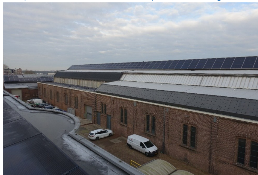
Afb. 124 Zuidwesthoek van het dak van het hoofdvolume. Het deel op de voorgrond heeft nog de oorspronkelijke contour.
