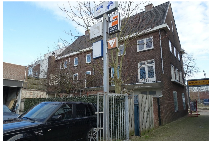
Afb. 219 Overzicht achtergevel vanaf het achterterrein.
