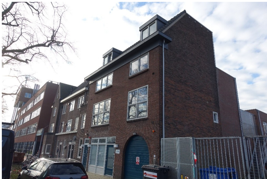
Afb. 211 Overzicht vierlaags voorbouw.
