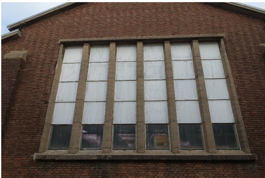
Afb. 128 Detail oorspronkelijk venster met stalen ramen in de zuidgevel.
