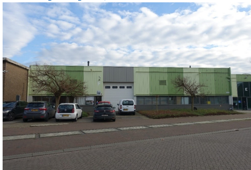
Afb. 202 Westgevel van gebouw 7.
