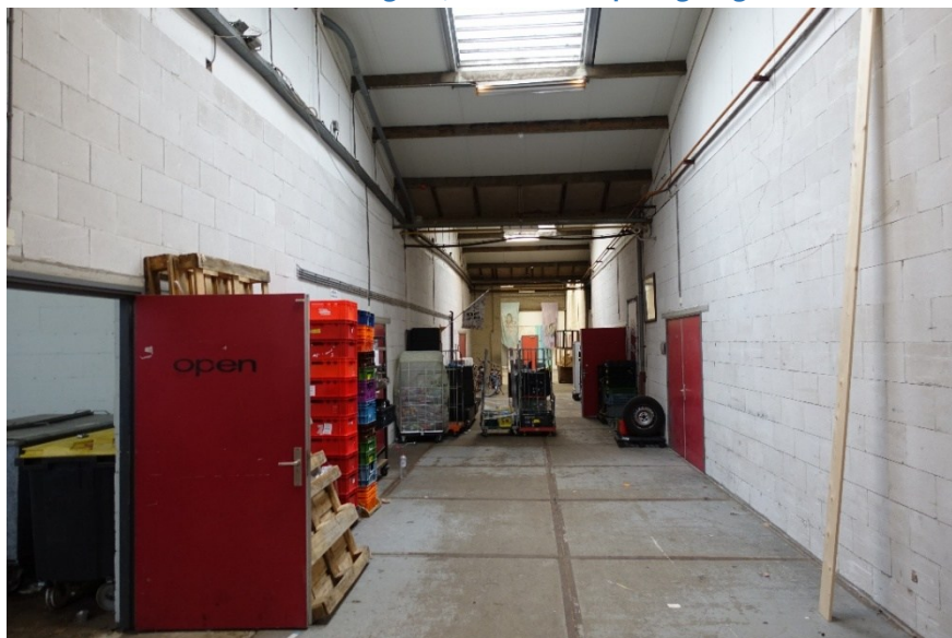
Afb. 189 Het interieur wordt bepaald door een later ingevoegde dwarsgang die in de aangrenzende bouwdelen doorloopt.
