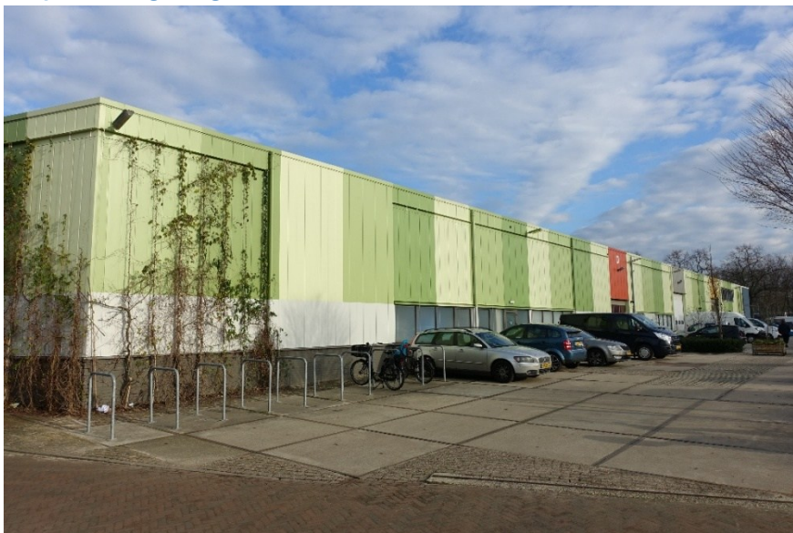
Afb. 204 Overzicht van de zuidgevel van gebouw 14.
