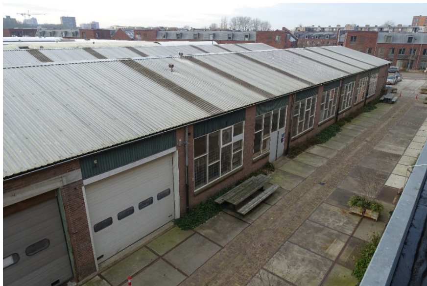
Afb. 185 Zicht over de bedrijfshal in westelijke richting.
