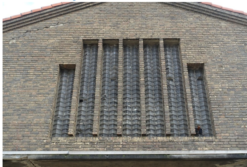
Afb. 168 Detail fraai venster met prismavormige glazen bouwstenen.
