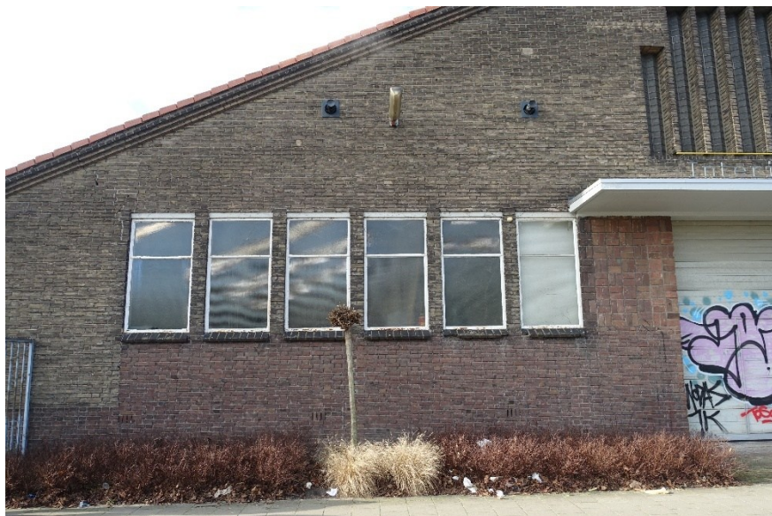
Afb. 161 Detail oorspronkelijke vensters in de oostgevel.
