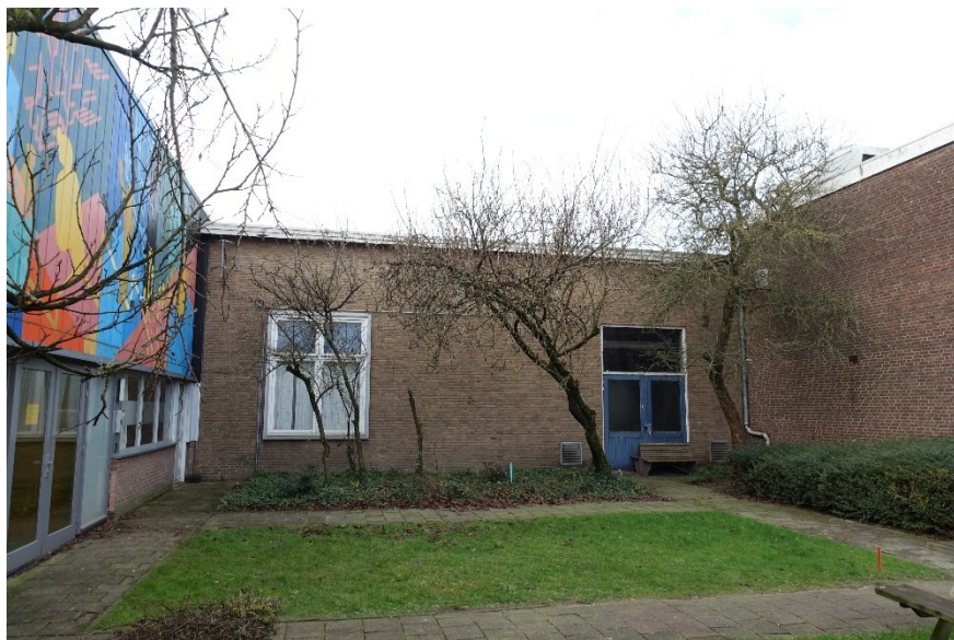
Afb. 194 Oostgevel van de bedrijfshal.
