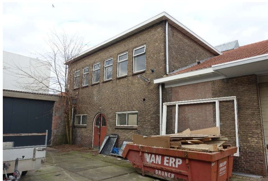
Afb. 163 Tweelaags middendeel van de zuidgevel.
