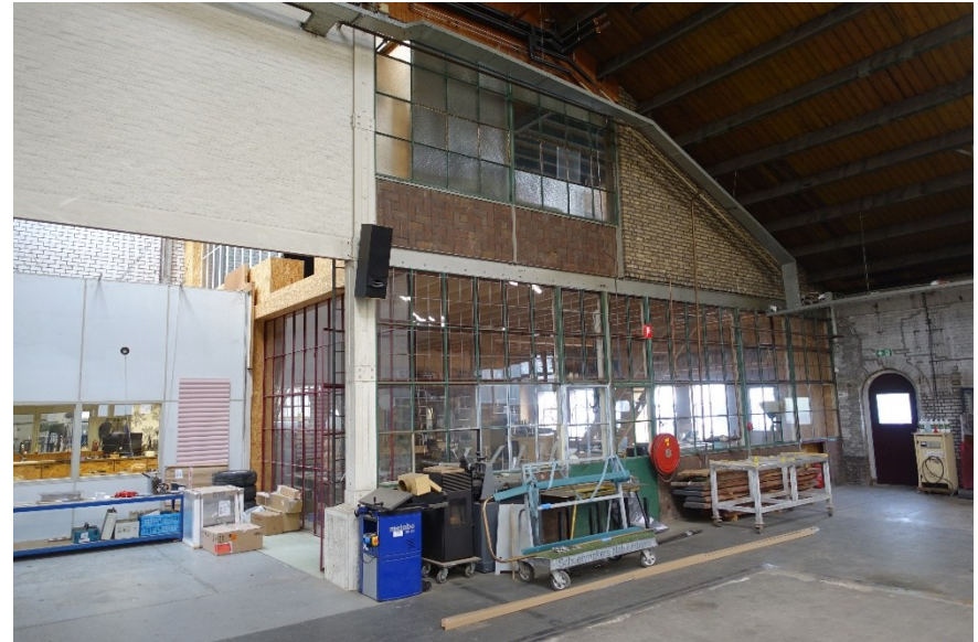
Afb. 171 Van het oorspronkelijke kantoor is nog een deel van de wanden met stalen puien bewaard gebleven.
