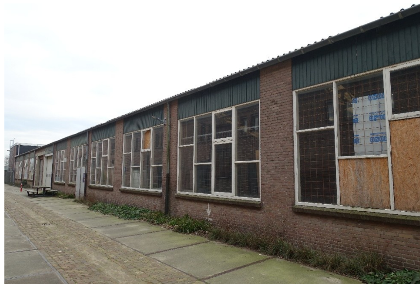
Afb. 186 De grotendeels oorspronkelijke noordgevel heeft een regelmatig repeterend karakter.
