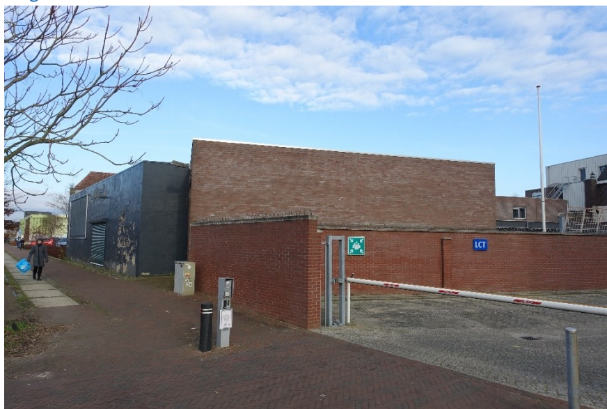
Afb. 223 Overzicht zuidzijde van het gebouw.
