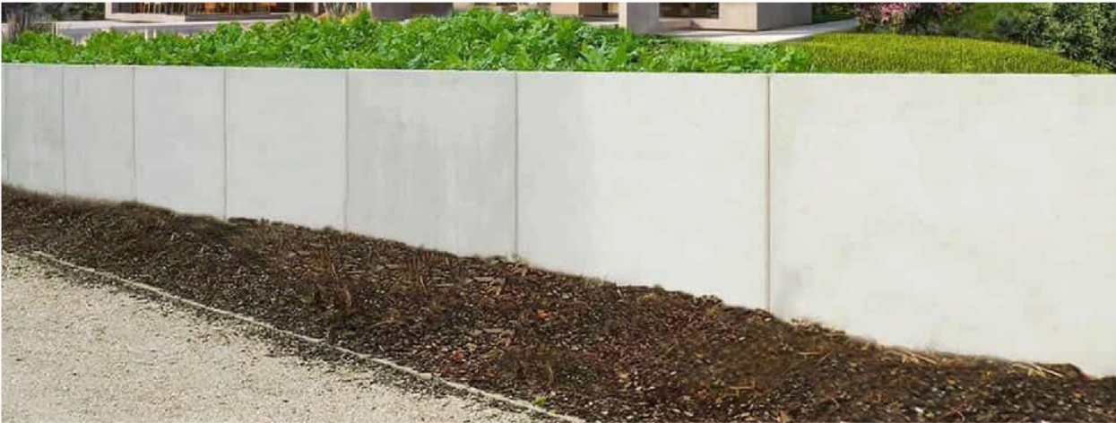
6. Keerwand, prefab beton L-elementen, ruw afgewerkt
