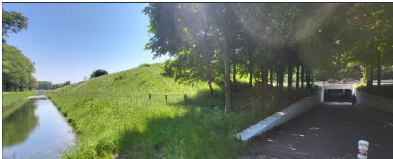
Figuur 4.5 Zicht op de in de huidige inrichting uitgerasterde taludwal ten zuiden van Staddijk en de bestaande fietstunnel.
