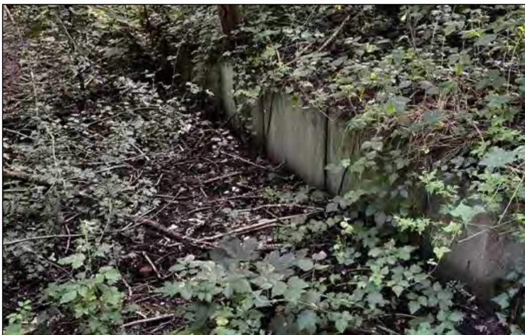
Figuur 2.6 Er loopt een muurtje van oost naar west door het bosje in 'Teersdijk (vak B)'.
