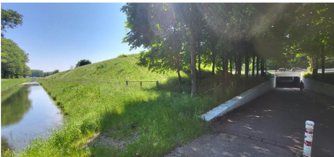
Figuur 3.6 Zicht op de niet toegankelijke taludwal ten zuiden van Staddijk en de bestaande fietstunnel.
