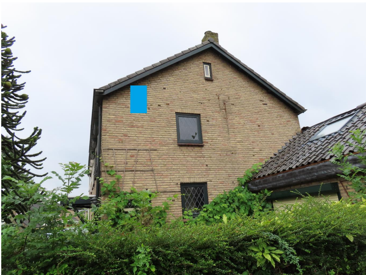
Figuur 6: Locatie vleermuis inbouwkraamkast. Bron: BNL Advies.
