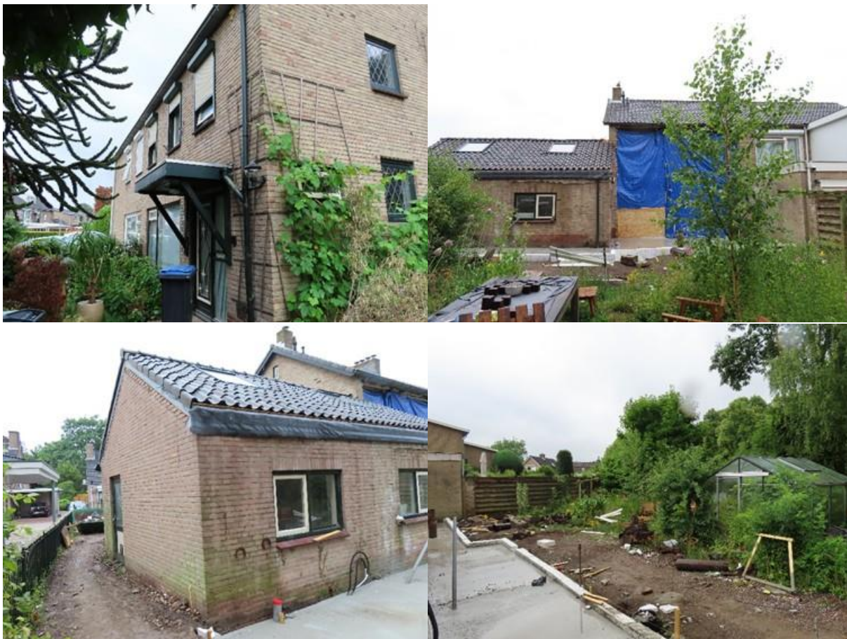
Figuur 2: Te verbouwen bebouwing en direct aangrenzende omgeving. Bron: BNL advies
