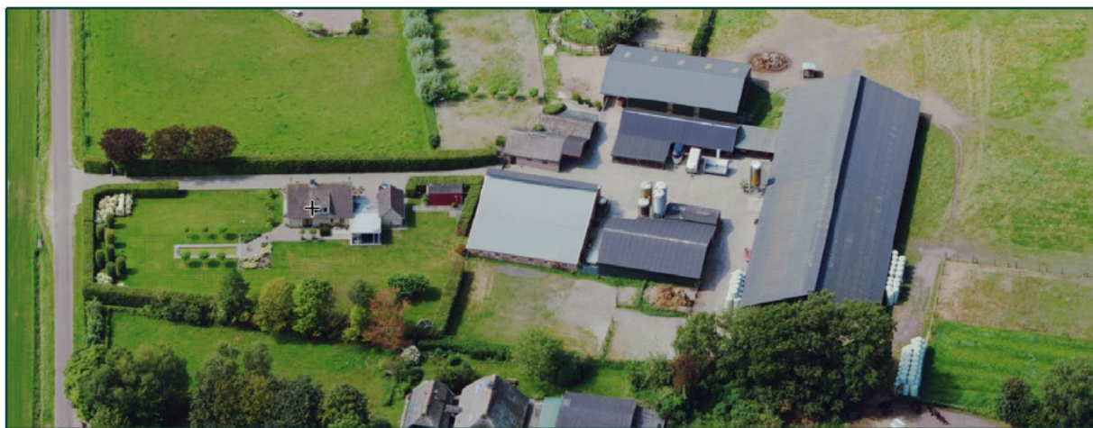
Afbeelding, bouwlocatie Goorsteeg 6 (Bron: Street Smart)
