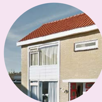
Kleinschalige maatschappelijke opvang Zaltbommel
