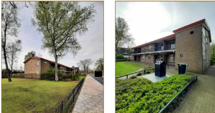
Figuur 3. Foto's van het plangebied (appartementencomplex). Links foto aanzicht plangebied genomen vanaf Krugerstraat ten noordoosten van het gebouw, rechts vanuit noordwestelijke richting.
