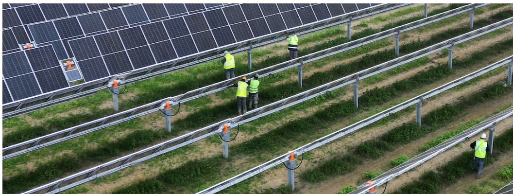
De laatste hand wordt gelegd aan een Mono axiaal tracker systeem van Soltigua in Hartungshof Duitsland
