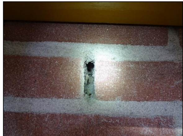
Figuur 10. Stootvoeg biedt toegang tot de spouw.
