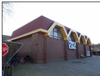
Figuur 4. Noordwestzijde gymzaal.
