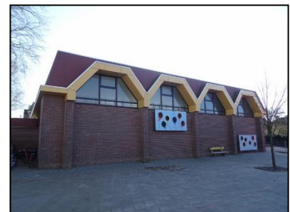
Figuur 5. Westzijde onderzoekslocatie.
