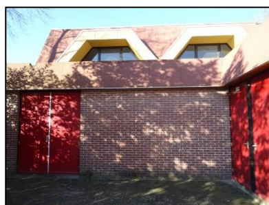
Figuur 7. Zuidoostzijde onderzoekslocatie.
