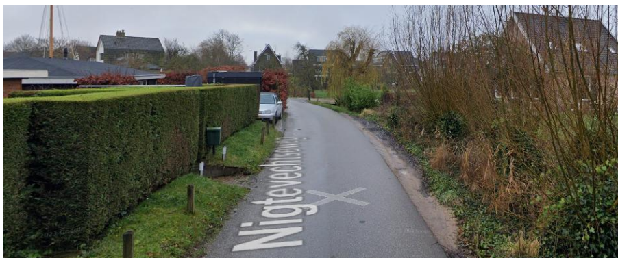
Figuur 6 Afbeelding situatie dijkvak 6
