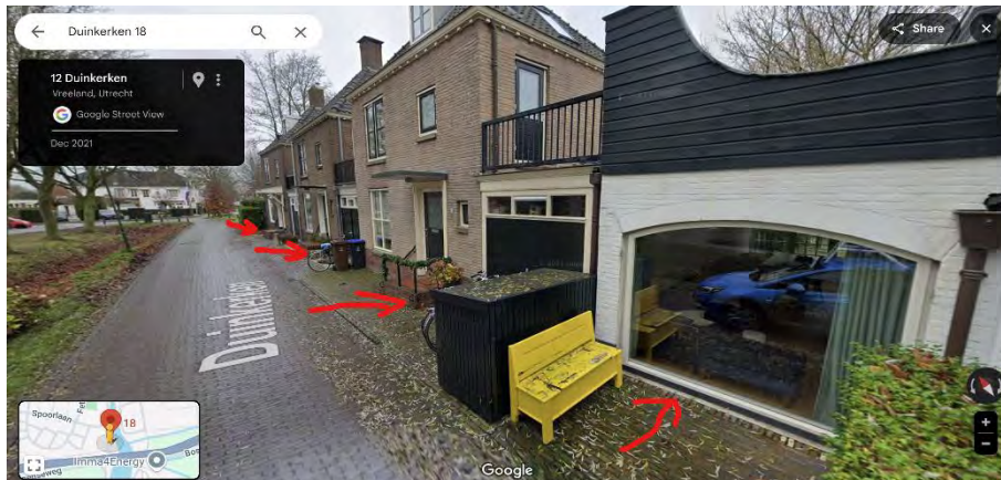
Figuur 11. Glazen pui en garagedeuren op het huidige maaiveld.
