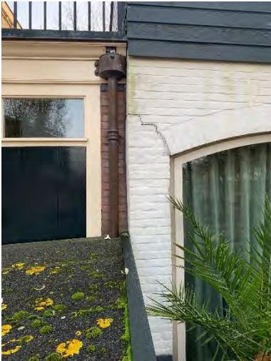
Scheefstand en diverse scheuren bij panden Duinkerken
