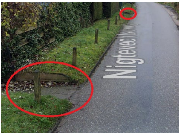
Figuur 7 Voorbeeld van een tuimeldijk die niet voldoet aan de waterveiligheidseisen
