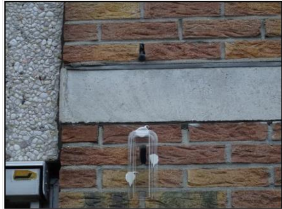
Figuur 6.4 Stootvoeg dichtgezet met vulschuim en een exclusion flap over een andere stootvoeg.
