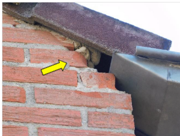
Figuur 5.4 Invlieglocatie gierzwaluw in Ruurlo in de kopgevel achter de dakgoot.
