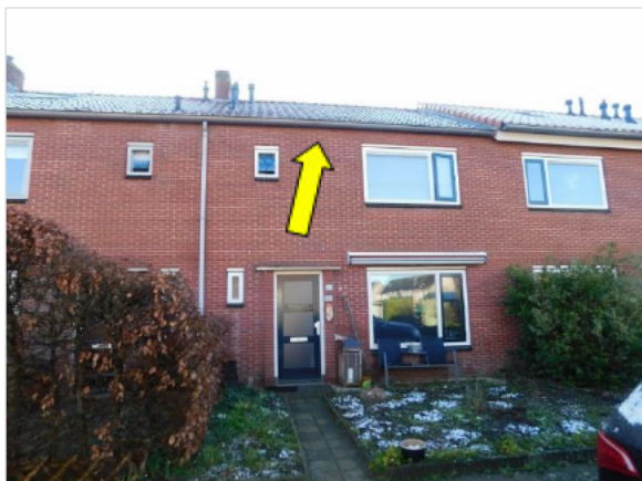
Figuur 5.3 Invlieglocatie gierzwaluw in Vorden ter hoogte van de dakgoot.
