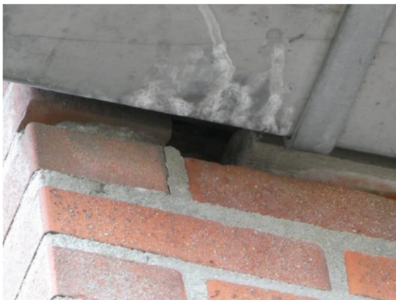
Figuur 5.4 Geschikte invliegopening voor gierzwaluwen onder de dakgoot.
