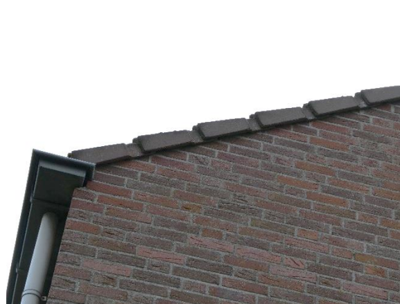
Figuur 5.6 Invliegopeningen voor vleermuizen bij overhangende kantpannen.
