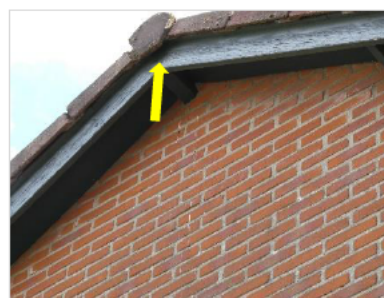
Figuur 5. De ruimte achter de nokvorst en kantpannen biedt toegang tot de bebouwing voor huismussen, gierzwaluwen en vleermuizen.
