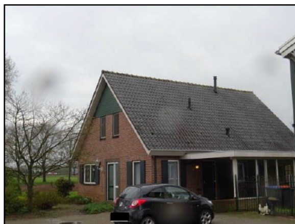
Figuur 13. Overdekt dakdeel met kantpannen.
