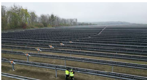
Aanleg van trackers (Soltigua) in trackerpark Hartungshof, Duitsland
