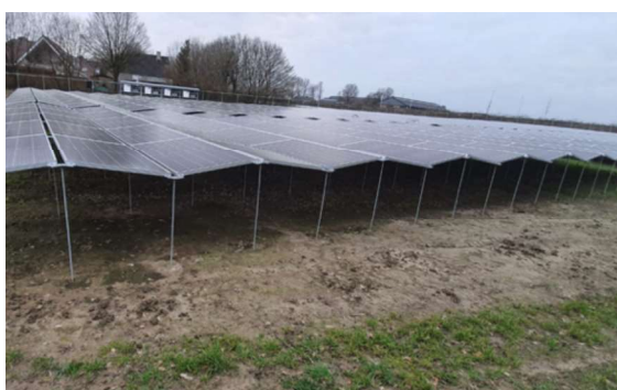
Extreem voorbeeld grond afdekking. Oostwest opstelling in Beekdalen Limburg
