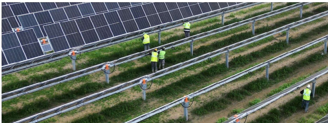
De laatste hand wordt gelegd aan een Mono axiaal tracker systeem van Soltigua in Hartungshof Duitsland
