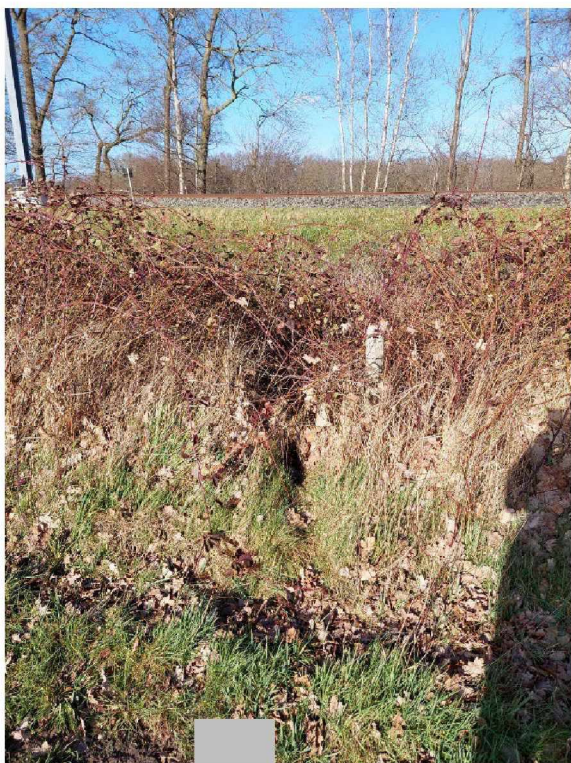
Afbeelding 4e: de braamstruweel scheiding tussen het plangebied en de spoorlijn bij deelgebied 2. Situatie op 13 maart 2023.
