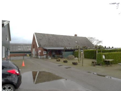
Figuur 2.4 Woning met uitbouw naar één van de schuren.
