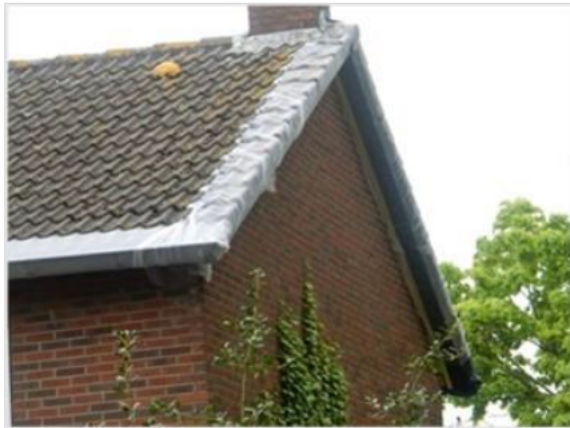
Figuur 8.3 Voorbeeld van afgeschermd kopse kant en afgeschermd dakgoot.
