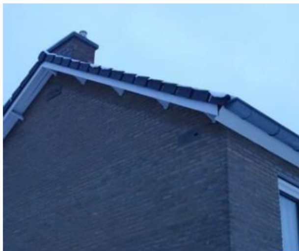
Figuur 8.7 Inbouwkast type IB GZ 03 ingebouwd een kopgevel.
