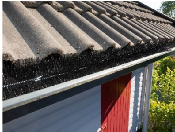
Figuur 8.4 Voorbeeld van toepassen spouwborstels in dakgoot.
