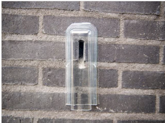
Figuur 8.7 Voorbeeld ongeschikt maken woning door exclusion flap over open stootvoeg.
