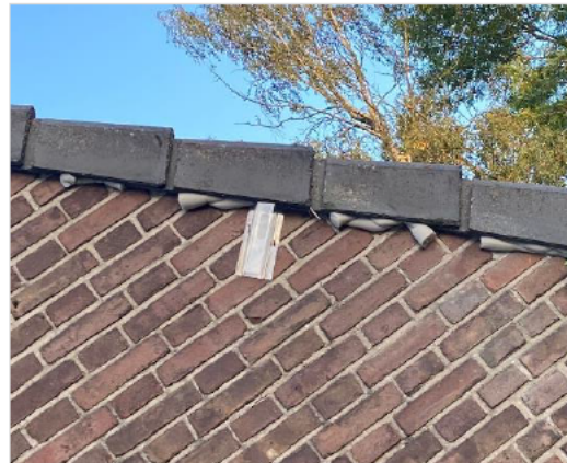
Figuur 8.8 Voorbeeld ongeschikt maken woning door exclusion flap tegen dakrand gecombineerd met vulschuim.
