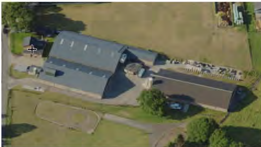
Afbeelding, bouwlocatie Brouwersbosweg 22 (Bron: Street Smart) ([03 juni 2023])
