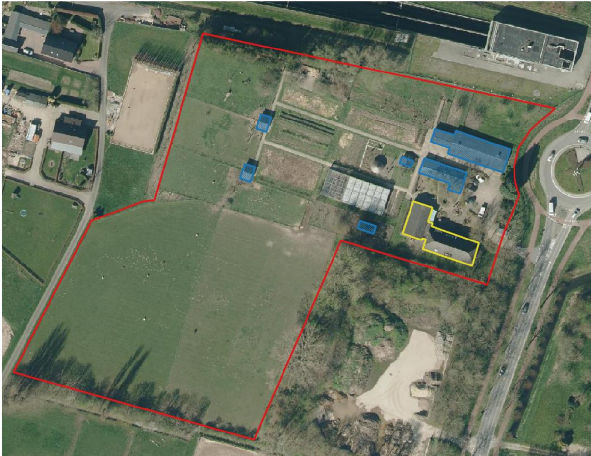
Afbeelding 1: Plangebied binnen de rode lijnen, met de bebouwing die wordt gesloopt in blauw en geel. In het geel omkaderde gebouw zijn de 6 huismusverblijfplaatsen waargenomen. (Bron: ABO-Milieuconsult B.V.).
