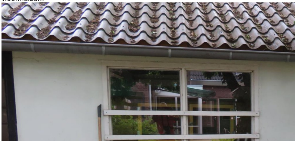
Afbeelding 11: gebouw 1 is gepleist en heeft een dak van aluminium platen.
