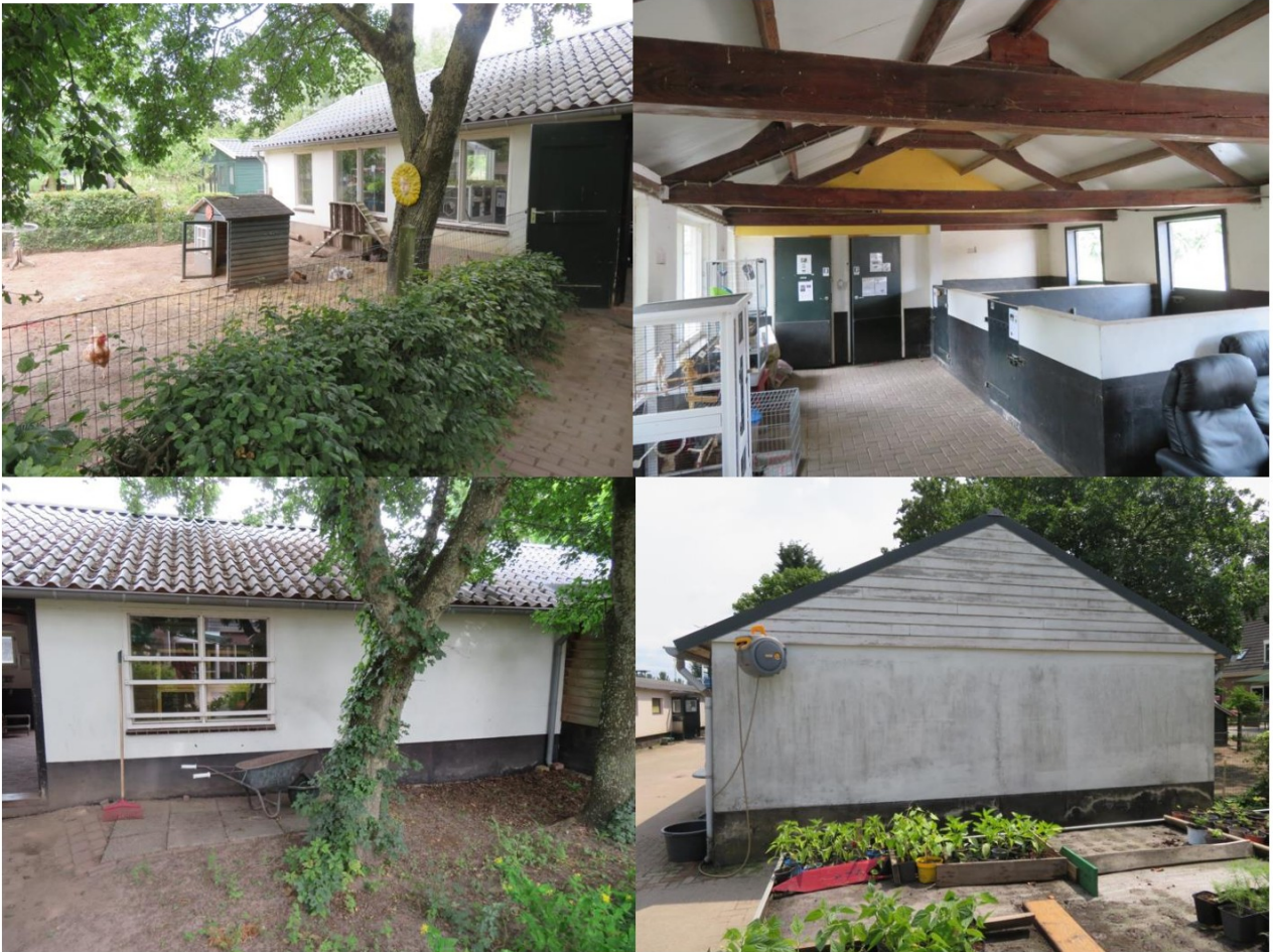
Abbeelding 6: buiten- en binnenkant gebouw 1
