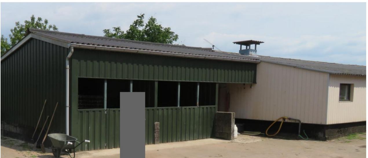
Afbeelding 16: gebouw 2 heeft een golfplaten dak en geen openingen in de zijgevels.
