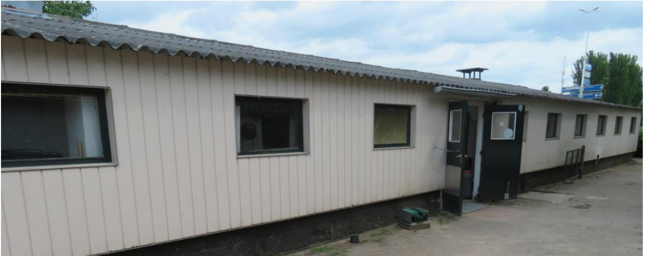
Afbeelding 12: gebouw 2: de houtskeletbouw is niet geschikt voor vleermuizen.
