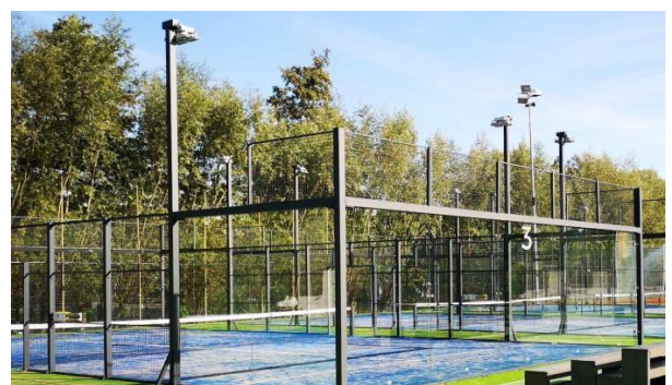
Figuur 8: lichtmast met armatuur
