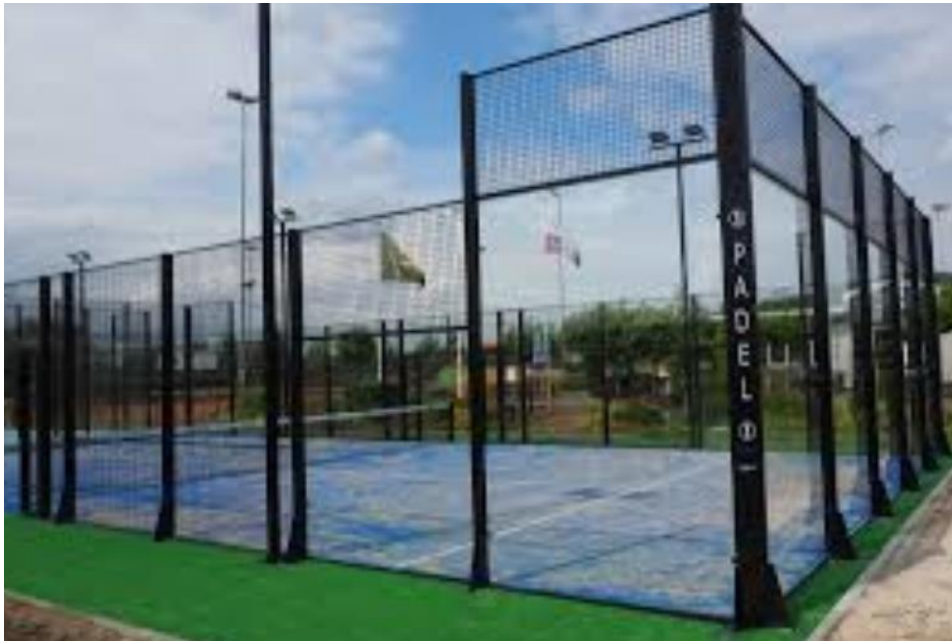
Figuur 4: vrijstaande lichtmast
