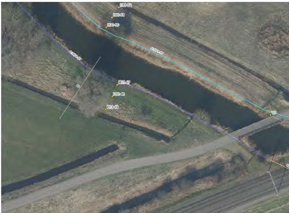
Figuur 8: Locatie piping beschouwing dijkvak 8
