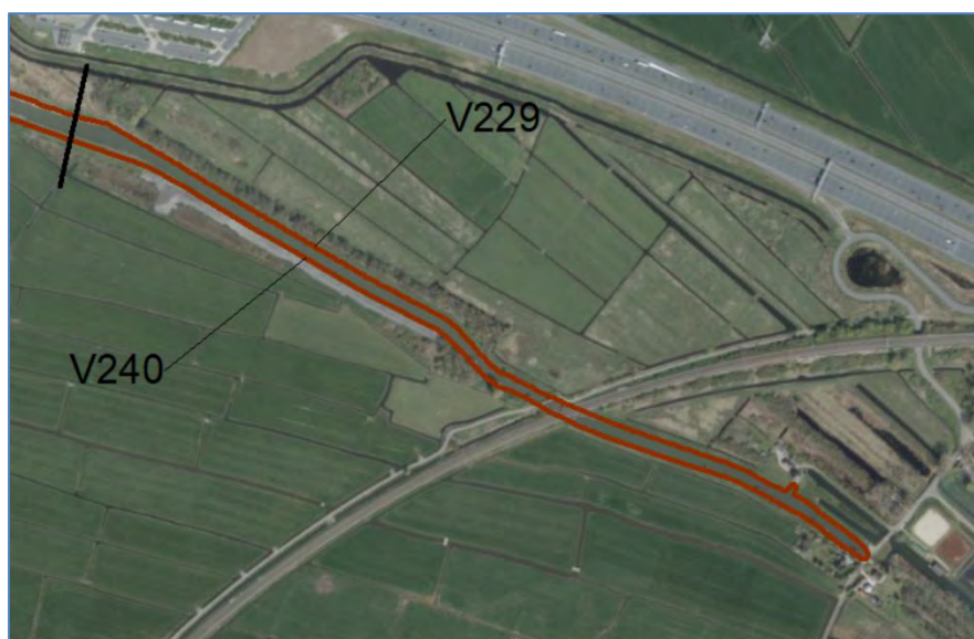
Figuur 2-1 Luchtfoto van het projectgebied met rechts onderin de weg Keverdijk
