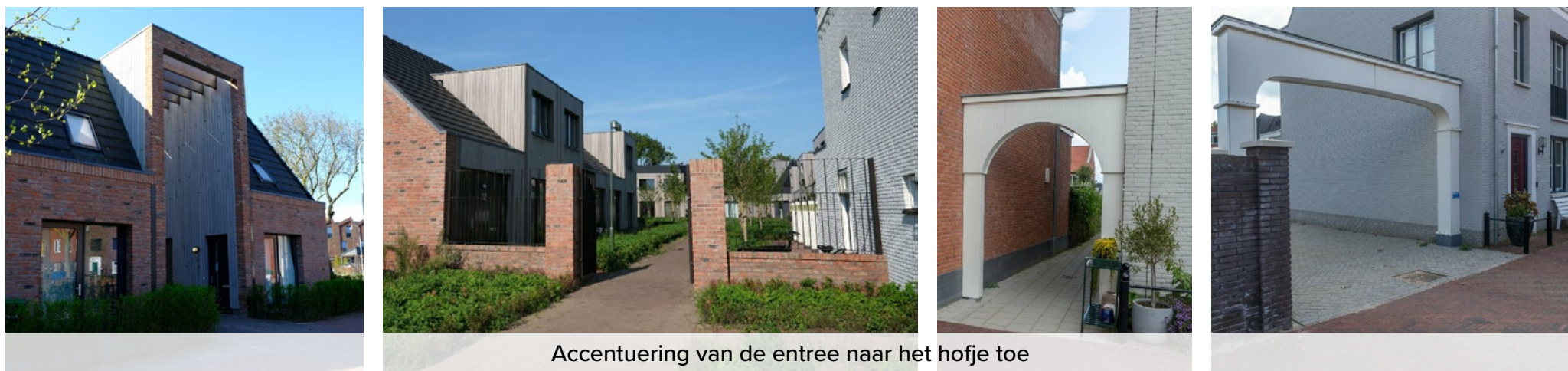
1 laag met kap, afwijking in materiaal mogelijk
