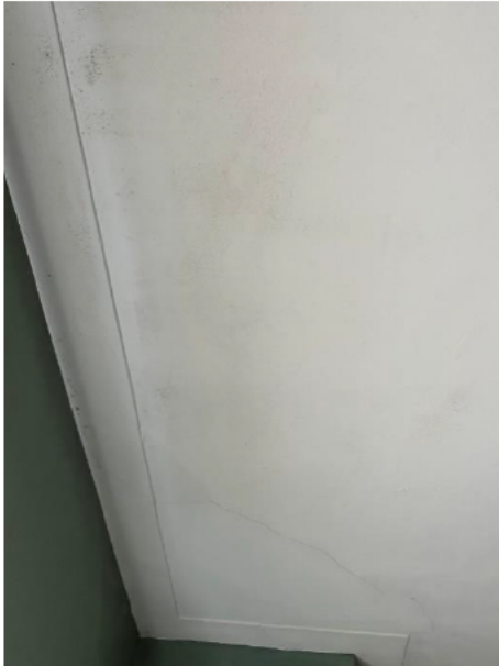
Foto's. Verschillende voorbeelden van vochtophoping en schimmelvorming in de woningen.
