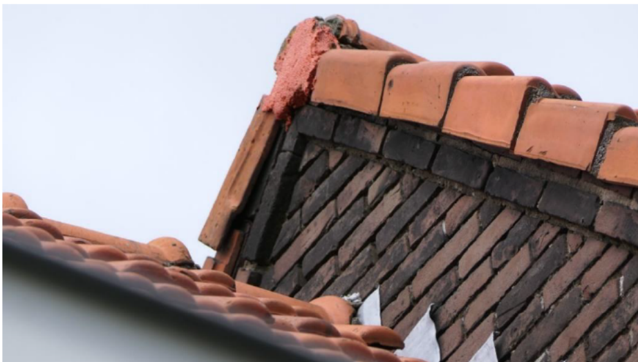
Foto's. Uitgevoerde noodmaatregelen om lekkages te verminderen.
