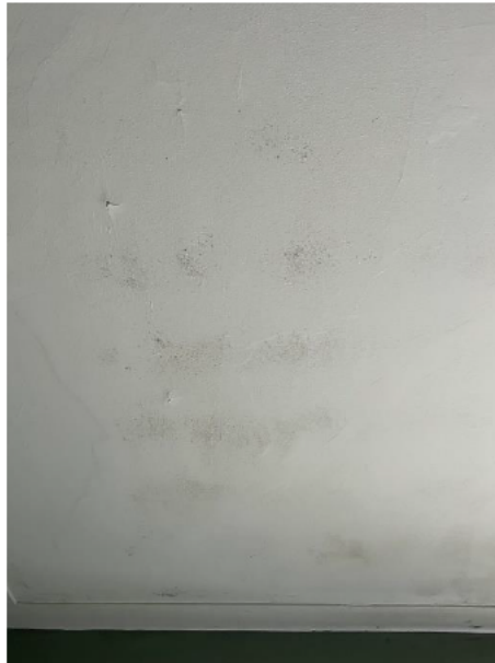
Foto's. Verschillende voorbeelden van vochtophoping en schimmelvorming in de woningen.
