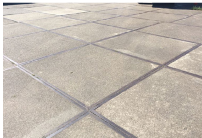
Afbeelding 47. Onderhoudspad door boomgaard naar ingang zonnenveld in grasbeton, op leidingzone stelconplaten.
