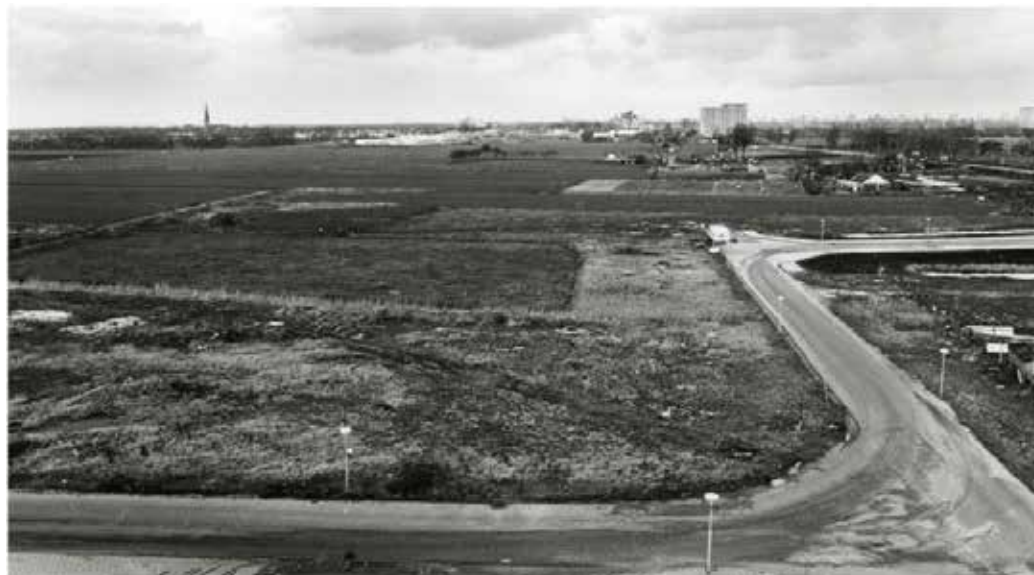
Huidige hoofdentree aan Bouwerij/Zagerij
