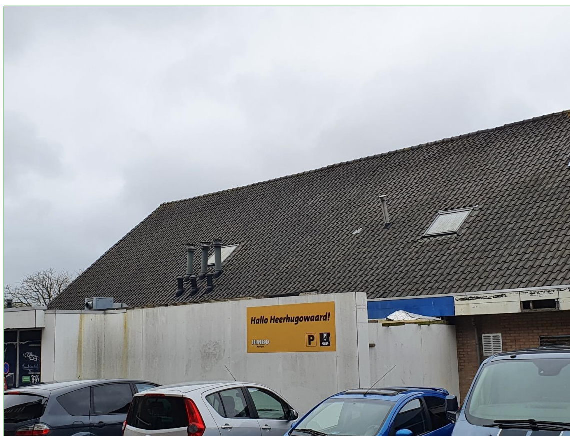
Een deel van het onderzochte dak in het plangebied.
