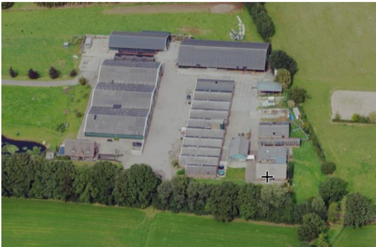
Figuur 1 Luchtfoto perceel Goorsteeg 16 te Putten (bron: Street Smart)
