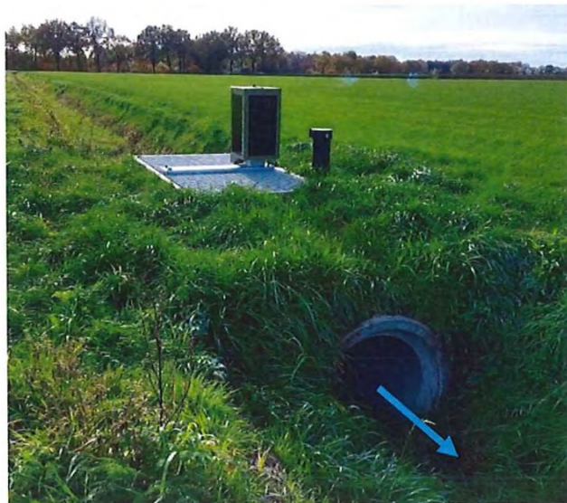
Figuur 2, zelfde type stuw elders in het beheergebied. Foto links is bovenstroomse kant, foto rechts benedenstrooms. De pijlen geven de stromingsrichting van het water weer.
