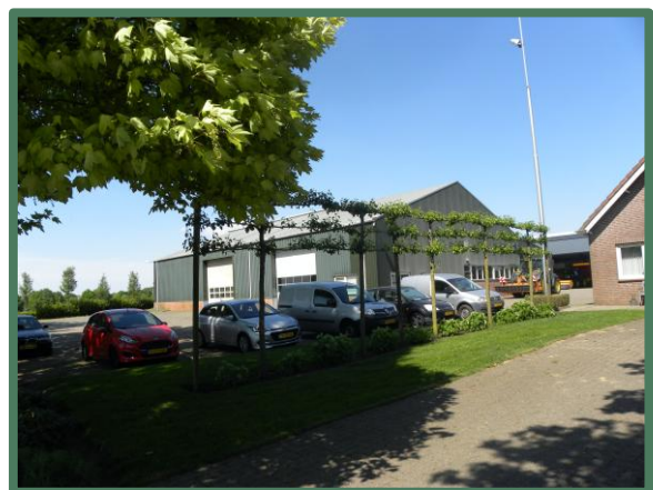
Foto 2: Overzicht op de bedrijfsloods vanaf de oprit.
