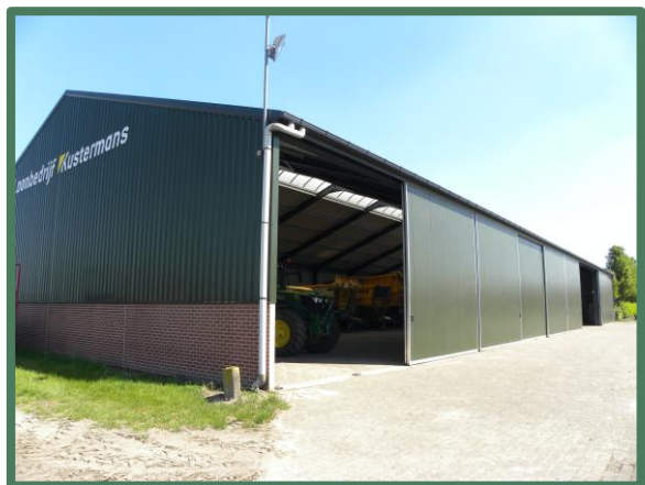
Foto 8: Noordelijk gelegen loods.
