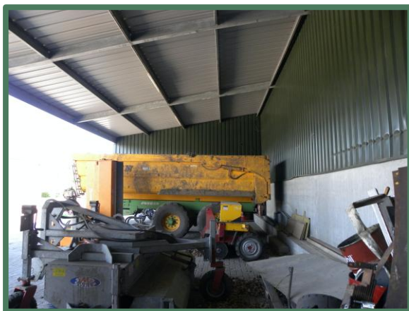
Foto 7: Open gedeelte van de loods.
