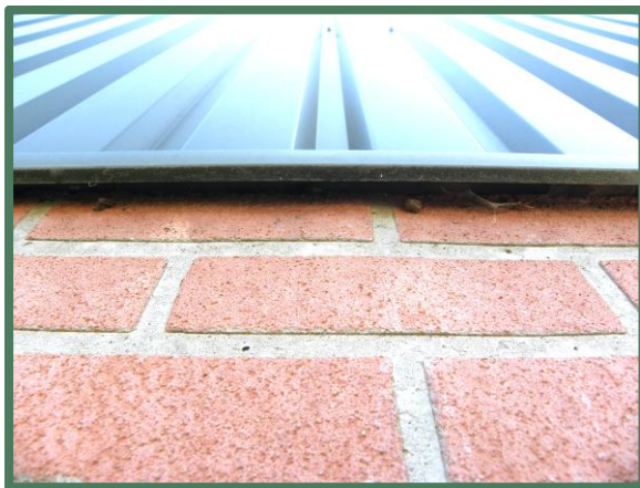
Foto 19: Ruimte onder damwandpaneel gesloten met panlat.
