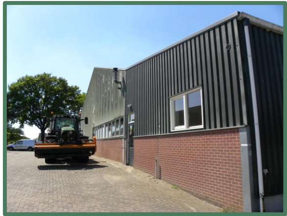
Foto 4: Oostelijke zijgevel vanaf het noordoosten.
