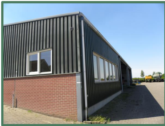
Foto 5: Noordelijke kopgevel, vanaf het noordoosten.
