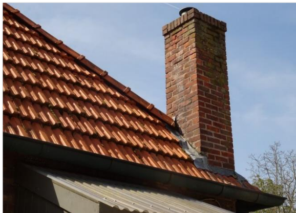
Figuur 3.19. Woning op de onderzoekslocatie met eventueel geschikte invliegopeningen onder de pannen.
