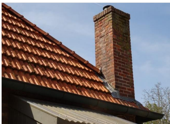
Figuur 5.21. Woning op de onderzoekslocatie met eventueel geschikte invliegopeningen onder de pannen.
