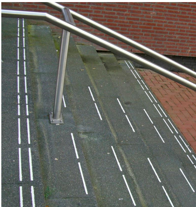
De trap is onderdeel van de geleideroute; bovenste en onderste treden zijn duidelijk.
