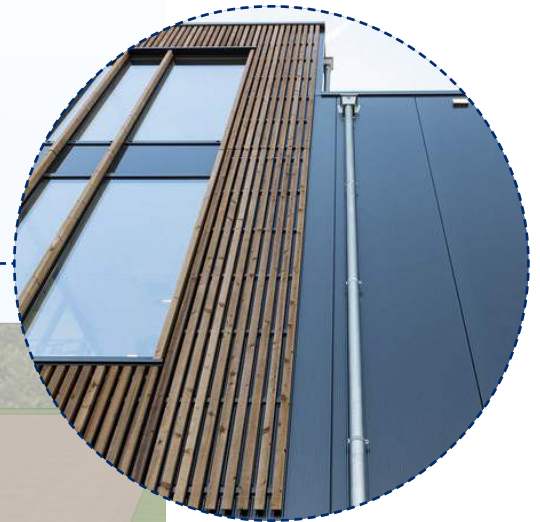
Houten latten bevestigd op sandwichpanelen
