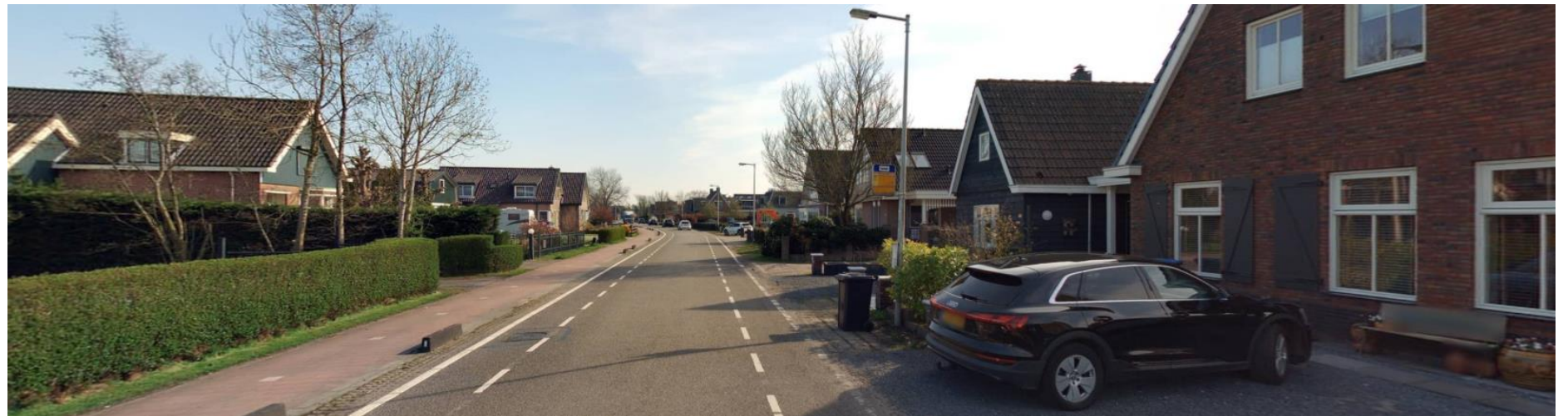
Figuur 4.22 Dichte bebouwing langs Den Ijp
